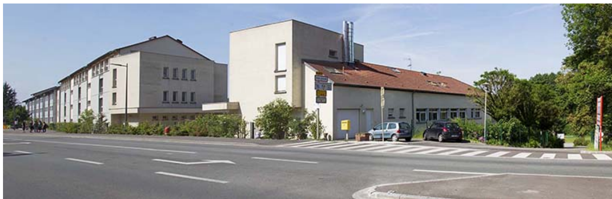
Façades de l'administration, des logements et de l'externat, rue de Turenne, vues du nord-est. 90, Valdoie, 95 rue de Turenne
