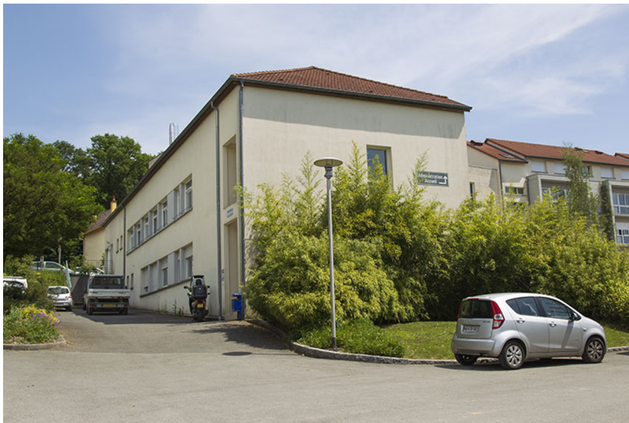
Angle nord-ouest de l'administration et des logements.
