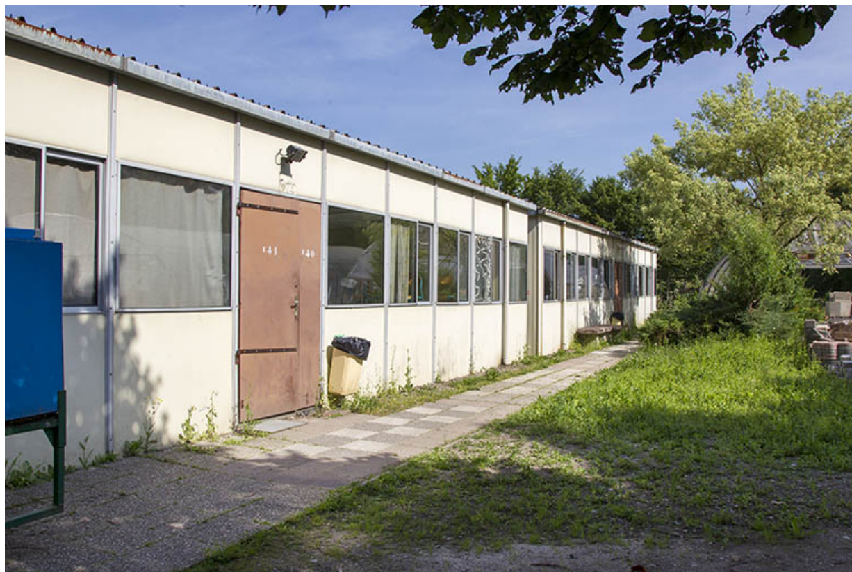
Façade postérieure des salles de cours nord-est.
