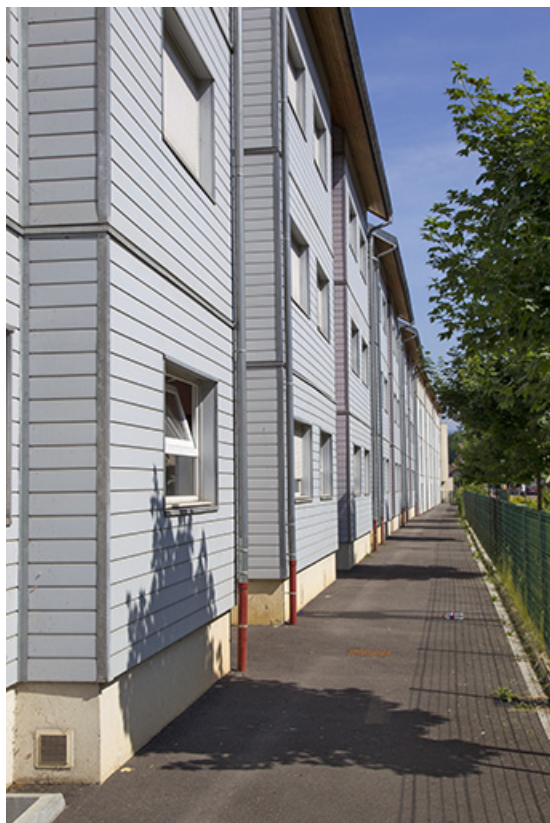
Détail de la façade postérieure est sur rue de l'externat nord-est et de l'internat, depuis le sud-est. 90, Valdoie, 95 rue de Turenne
