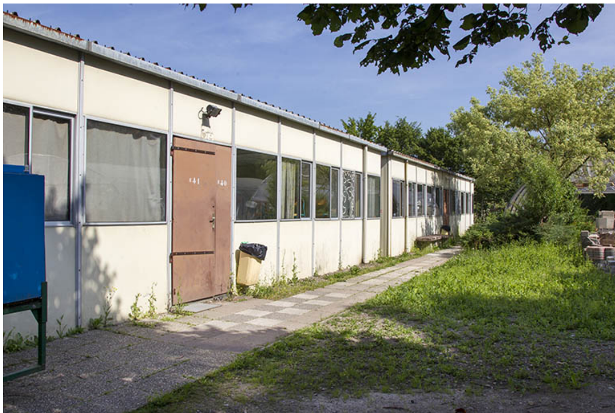
Façade postérieure des salles de cours nord-est.
