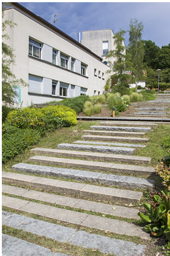
Escalier le long de la façade sud de l'administration.
