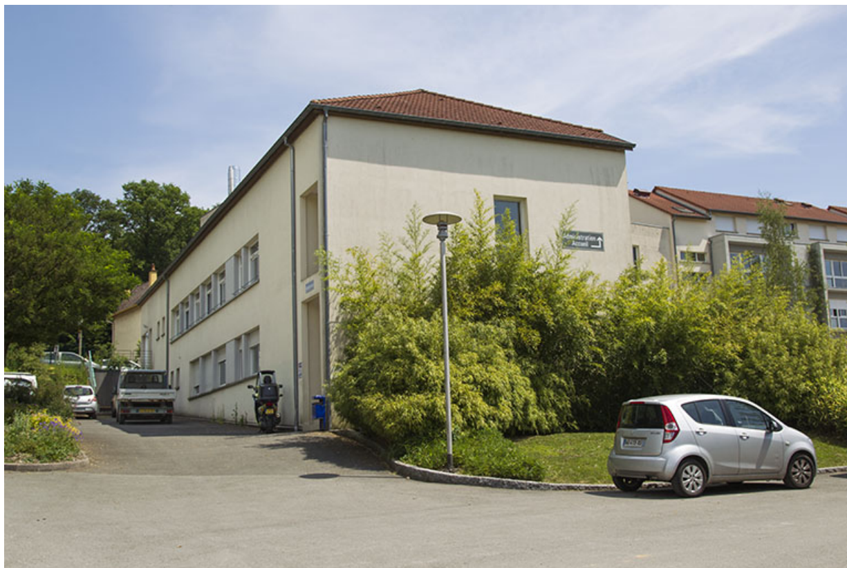
Angle nord-ouest de l'administration et des logements.
