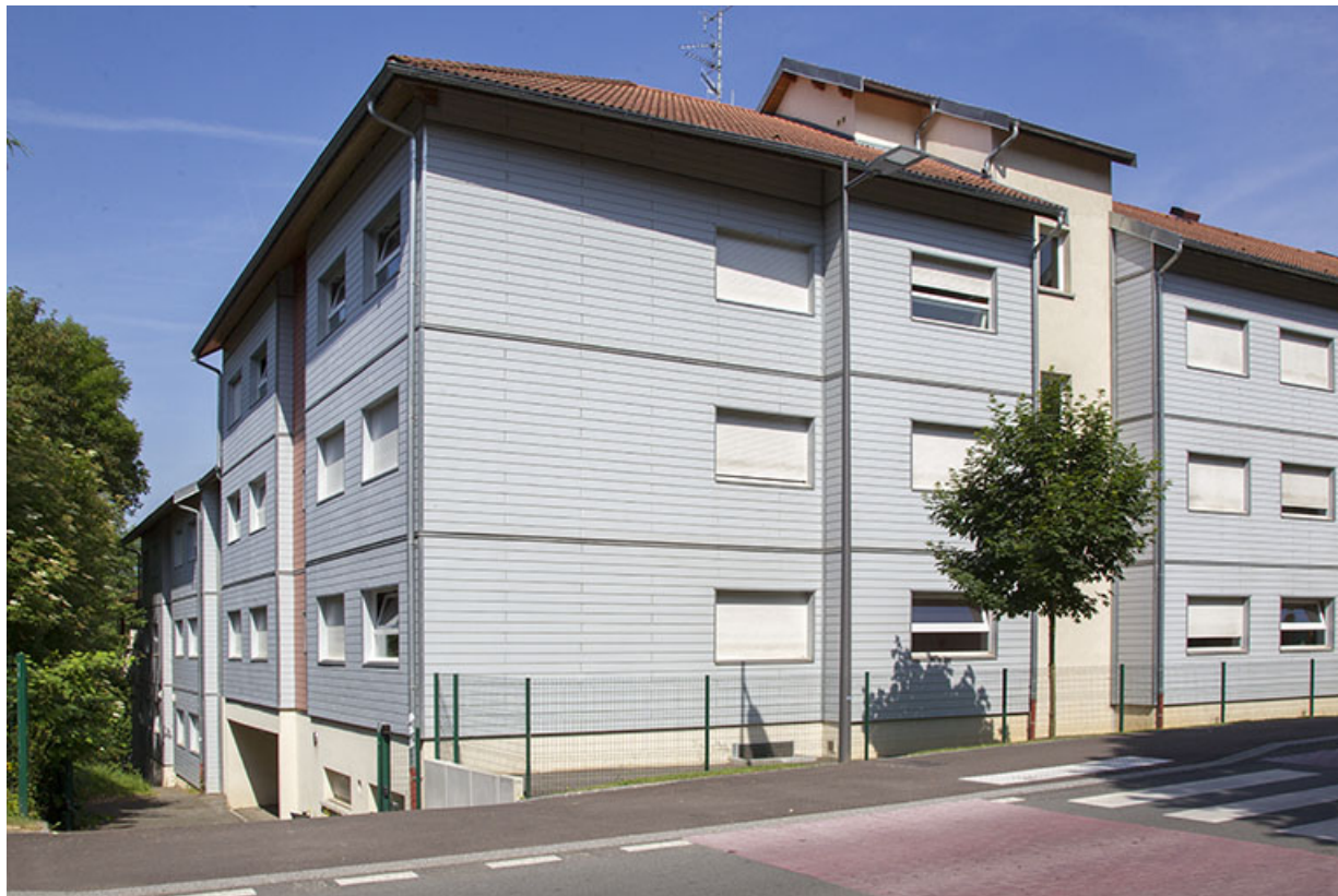
Pignon sud de l'internat, angle sud-est.
