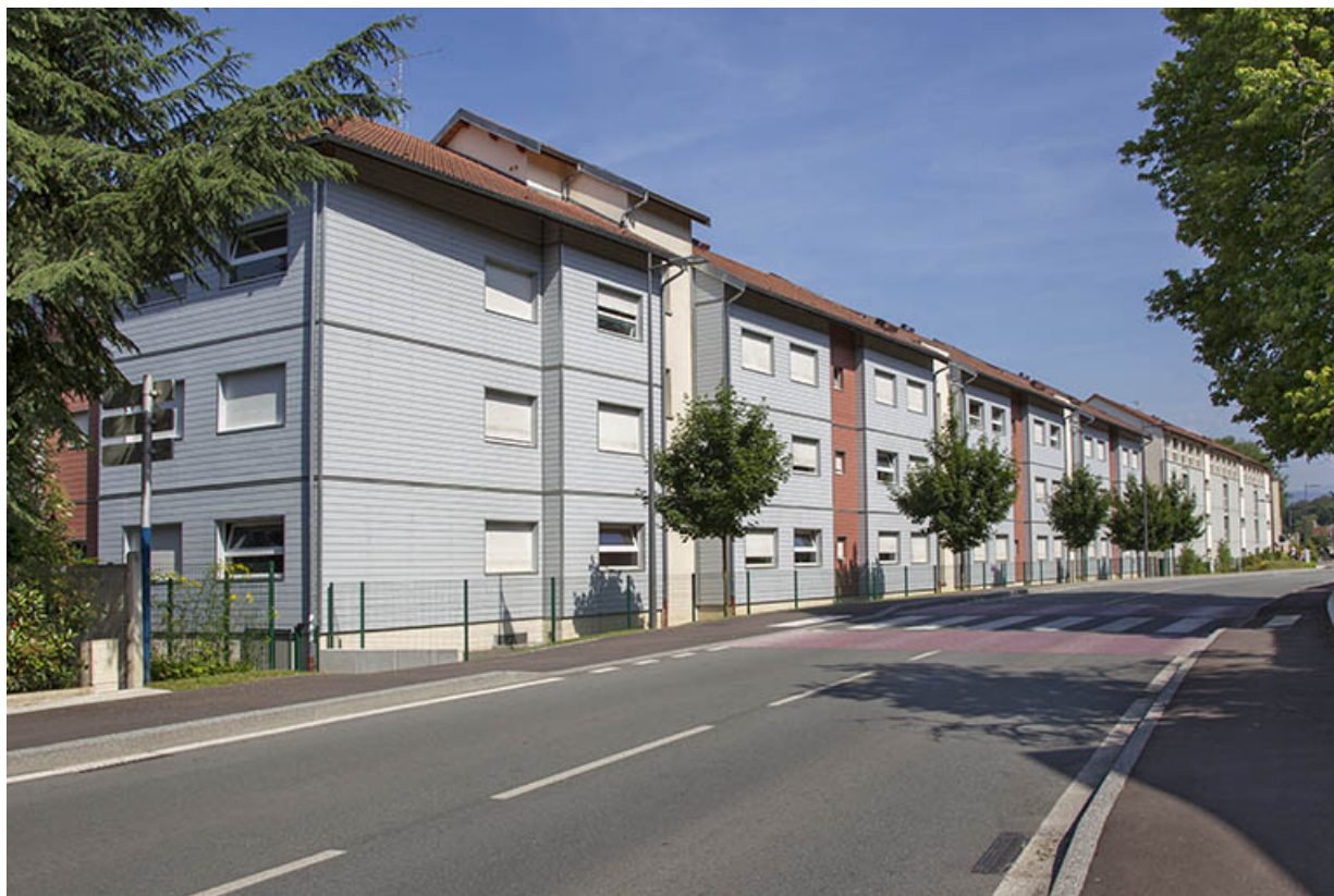
Façade postérieure est sur rue de l'externat nord-est et de l'internat, depuis le sud-est.
