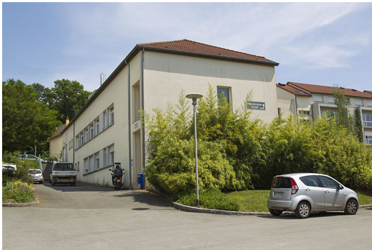
Angle nord-ouest de l'administration et des logements.
