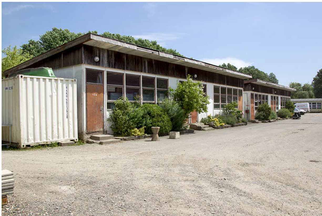
Façades antérieures des salles de cours au sud.
