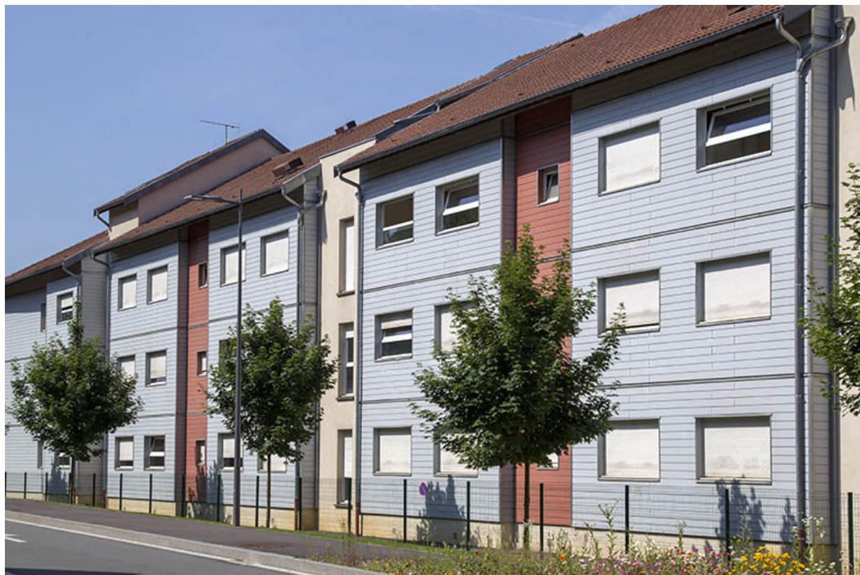
Détail de la façade postérieure est sur rue de l'internat.
