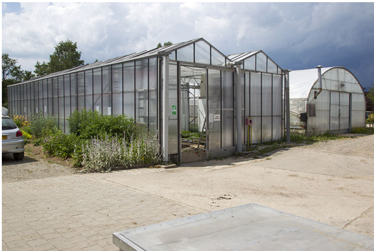
Serres au nord-ouest vues du sud-est.
