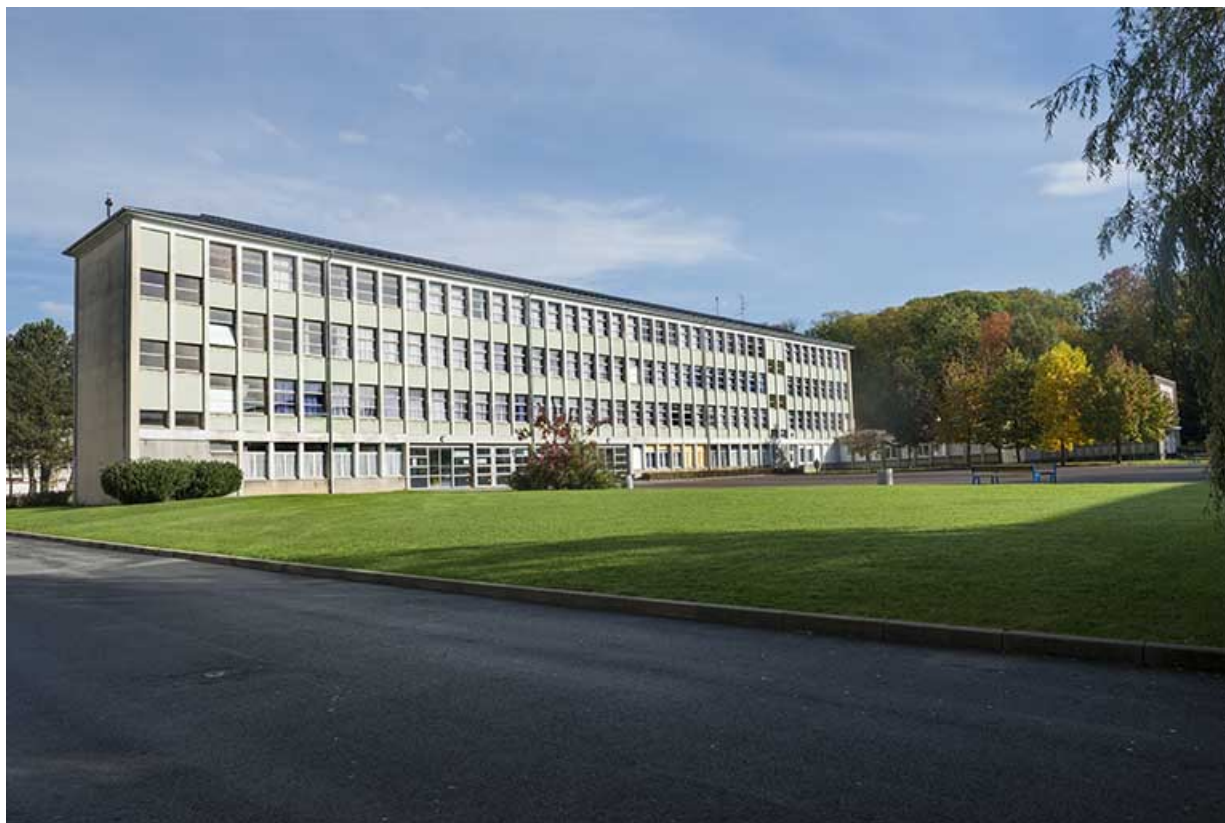
Angle sud-ouest et façade sud de l'externat du pôle tertiaire.
