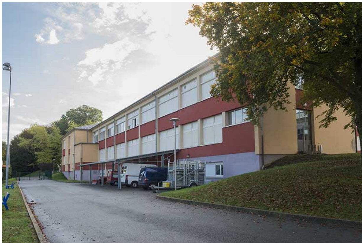
Façade intérieure nord de la barre nord de l'externat du pôle industriel et métiers de la mode. 90, Belfort, 3 rue Louis Marchal
