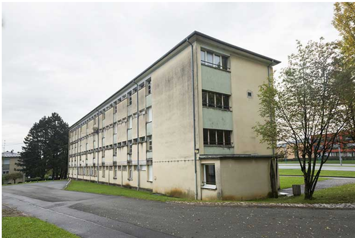
Angle sud-ouest de l'internat de garçons ouest.
