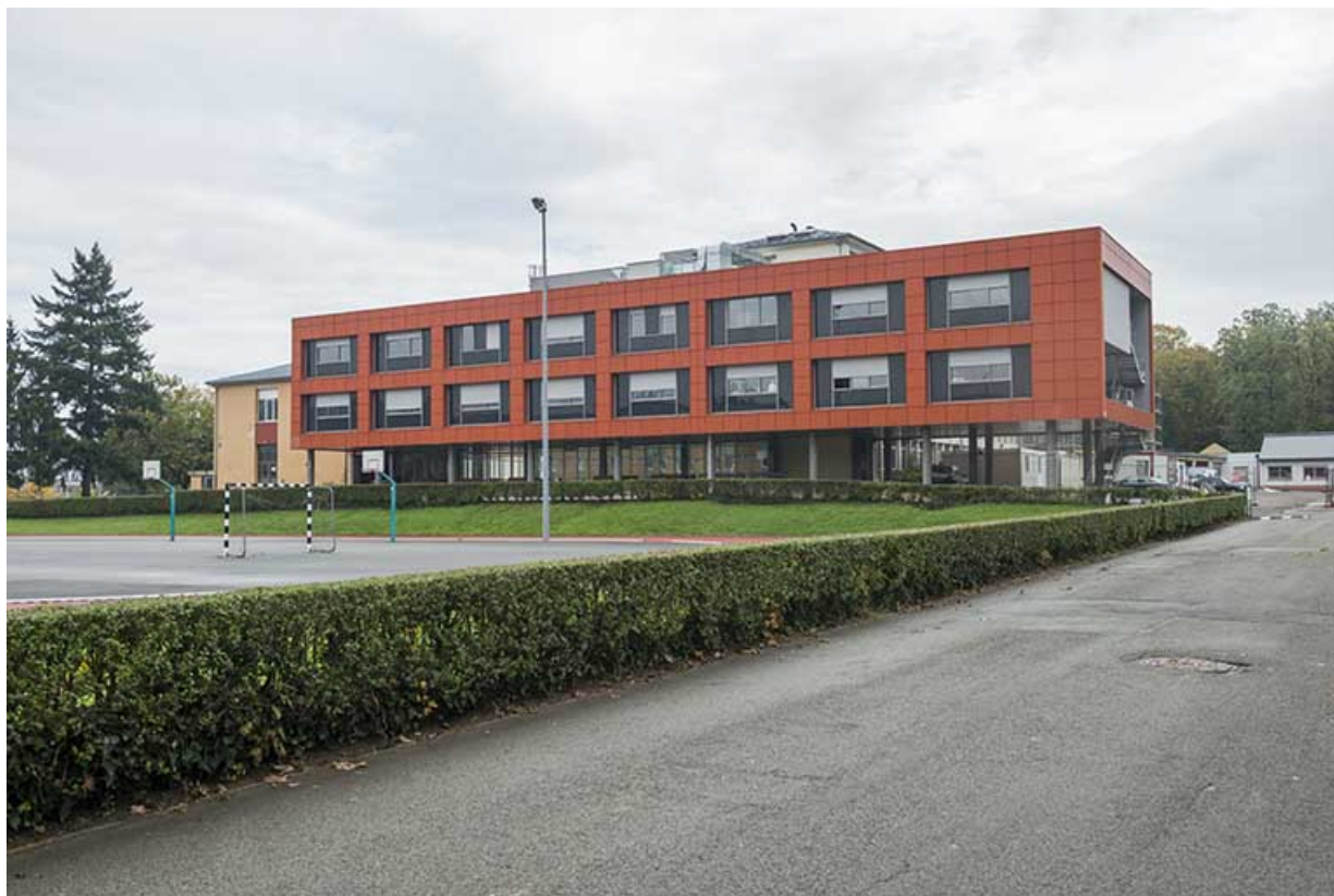
Façade ouest est et angle sud-ouest du pôle scientifique.
