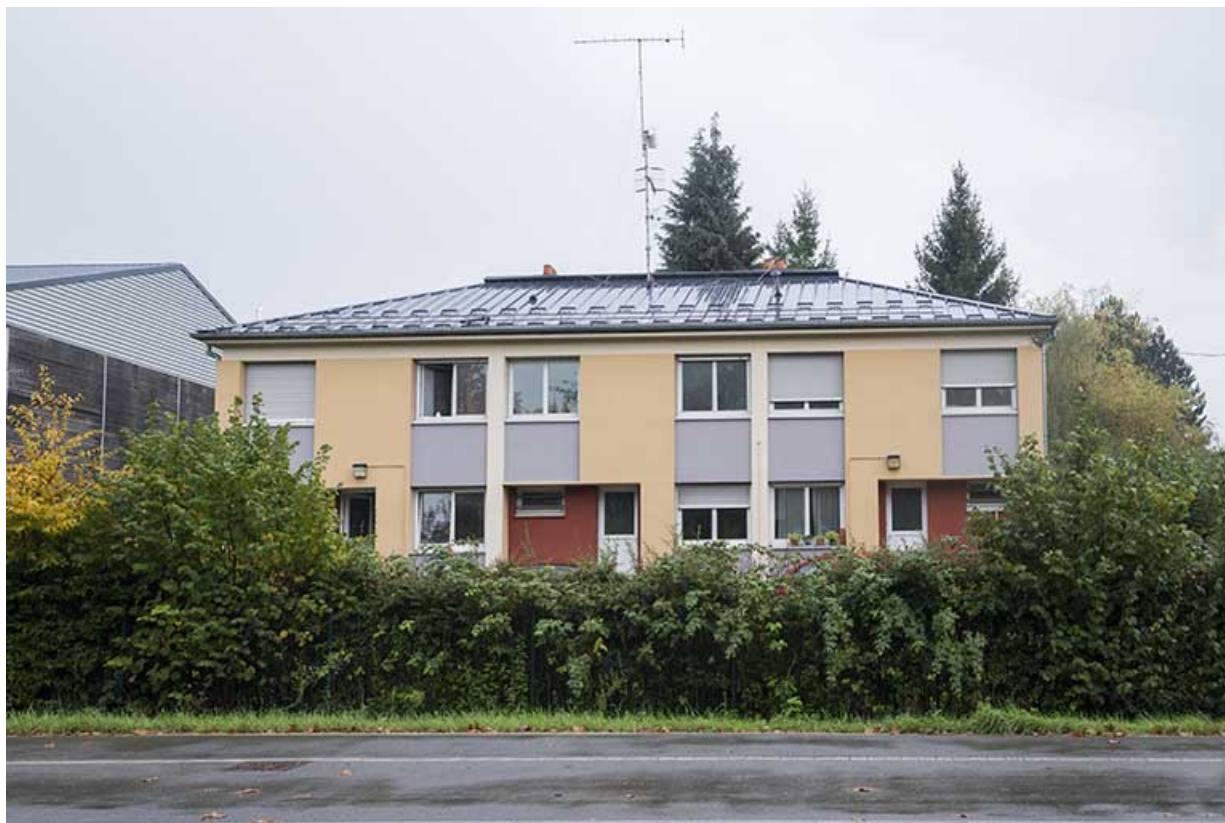
Façade nord du bloc des logements nord.
