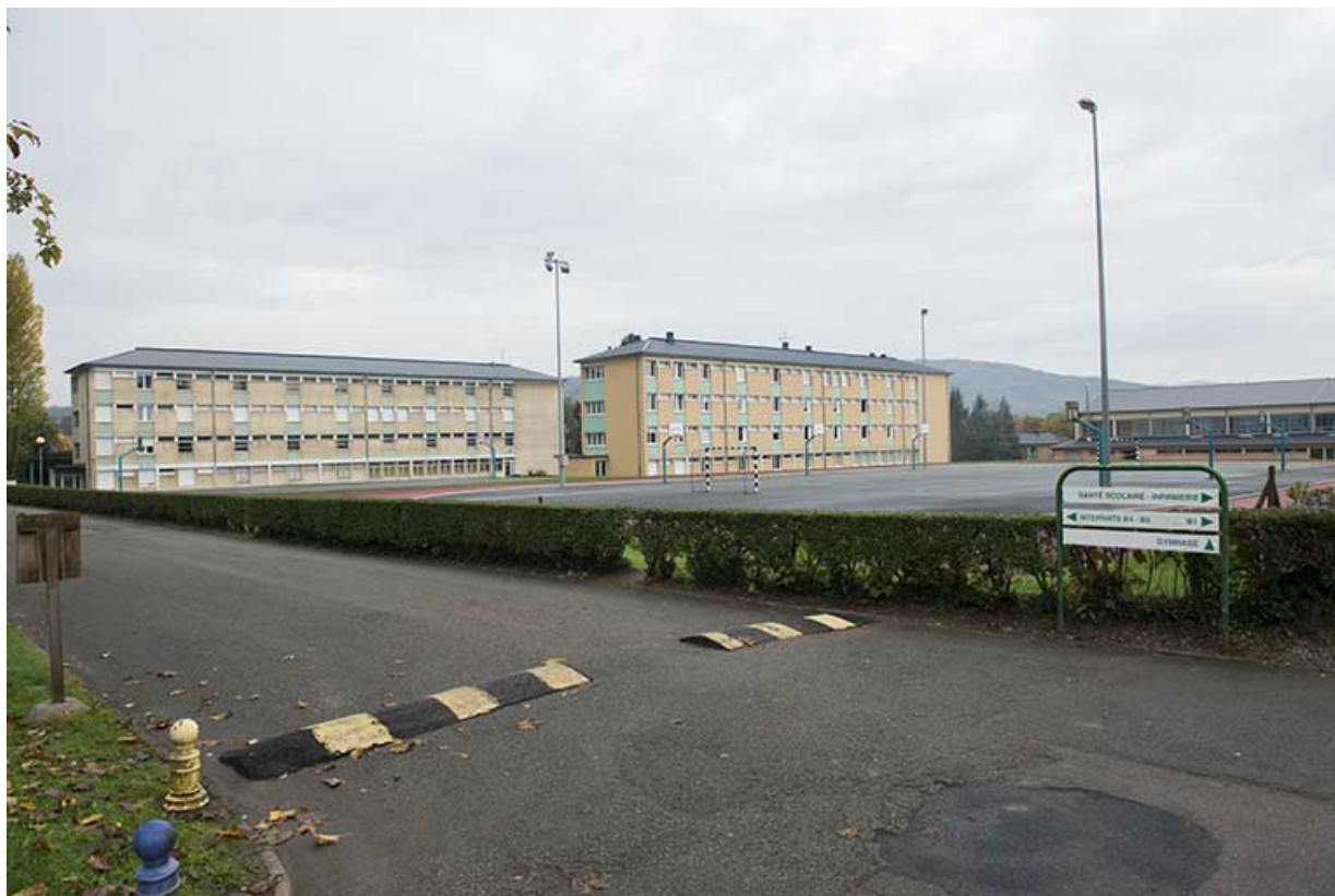
Les façades est et pignons sud des internats de garçons ouest et est, devant le stade.
