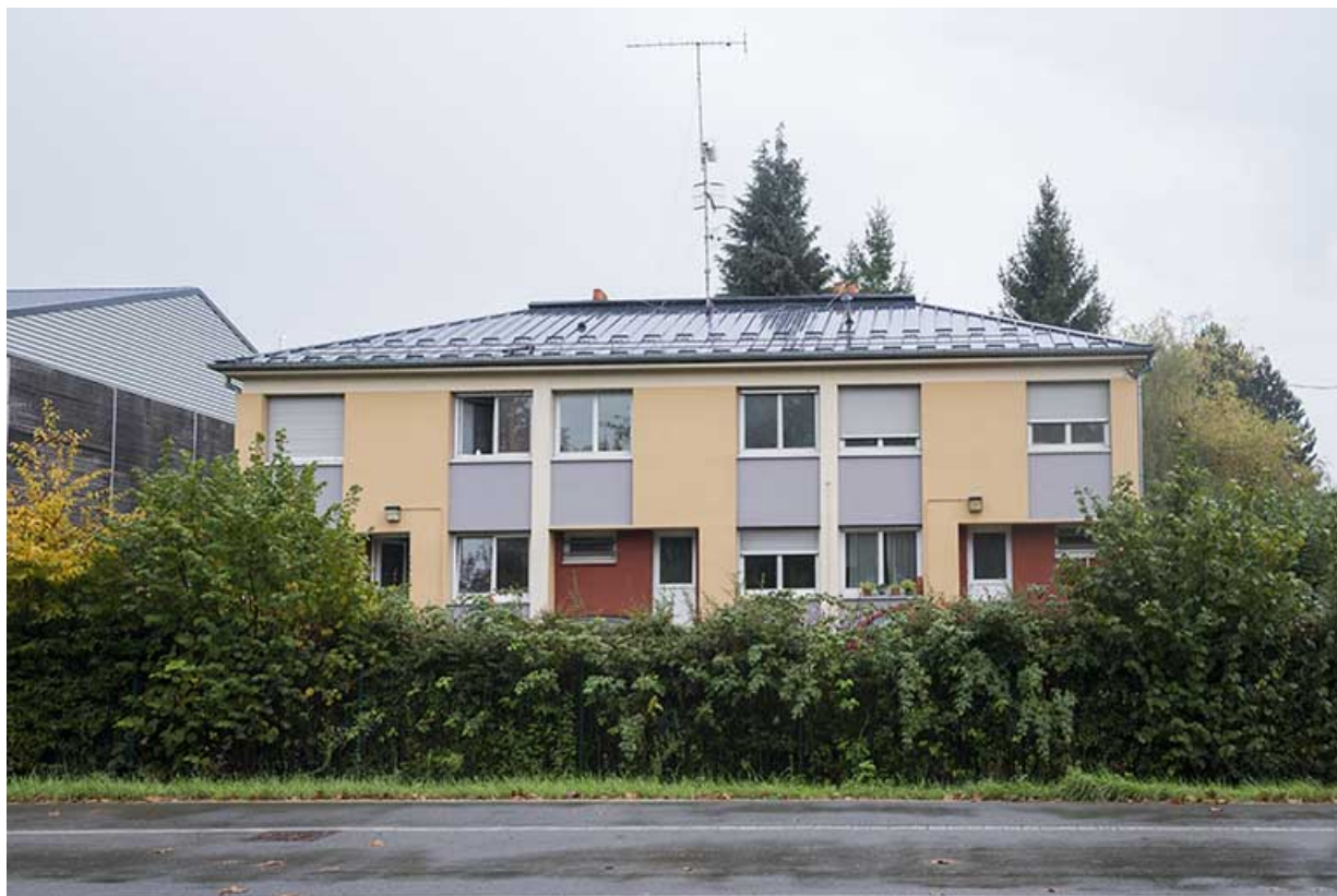
Façade nord du bloc des logements nord.
