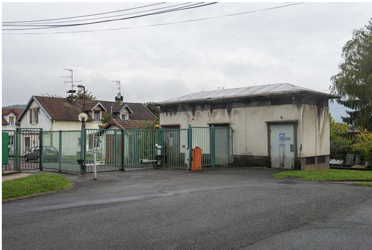
Transformateur et entrée du personnel au nord-ouest par la rue Jardon. 90, Belfort, 3 rue Louis Marchal
