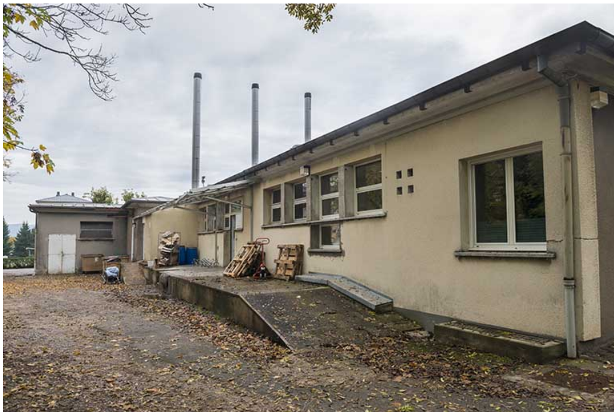
Angle sud-ouest et détail de la façade ouest de la restauration.
