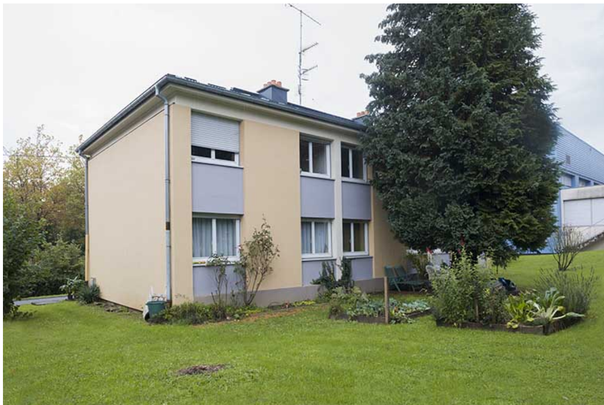
Angle sud-ouest du bloc de logements au nord.
