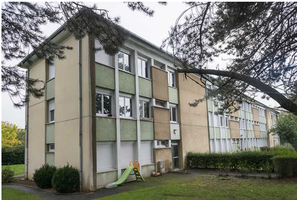
Façade est de la barre de logements.
