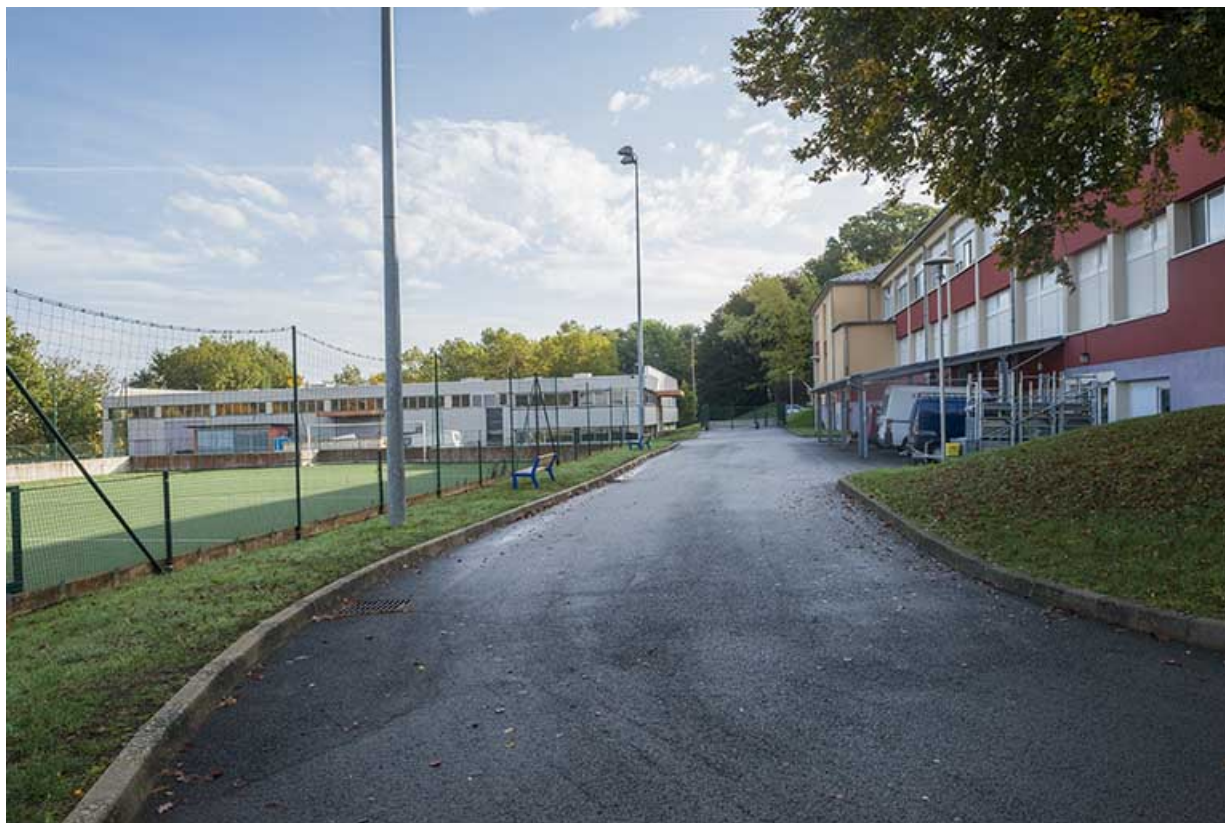
Accès entre la barre nord de l'externat du pôle industriel et métiers de la mode et l'atelier de chaudronnerie. 90, Belfort, 3 rue Louis Marchal
