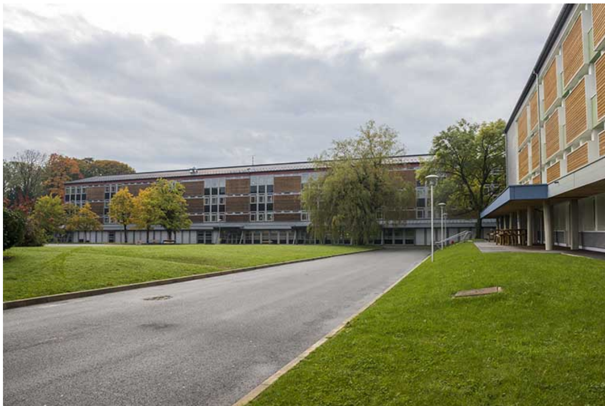
Façade nord de l'externat de cours généraux et du pôle sanitaire, façade est de l'externat internat de filles. 90, Belfort, 3 rue Louis Marchal
