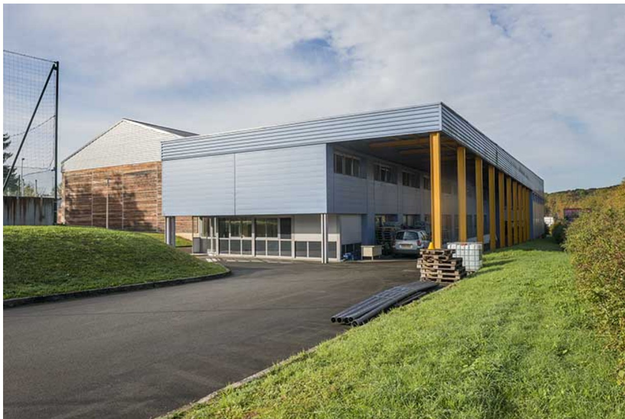
Angle nord-est du pôle logistique et pignon est du gymnase.
