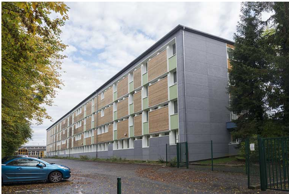
Angle sud-ouest et façade ouest de l'externat et internat de filles.
