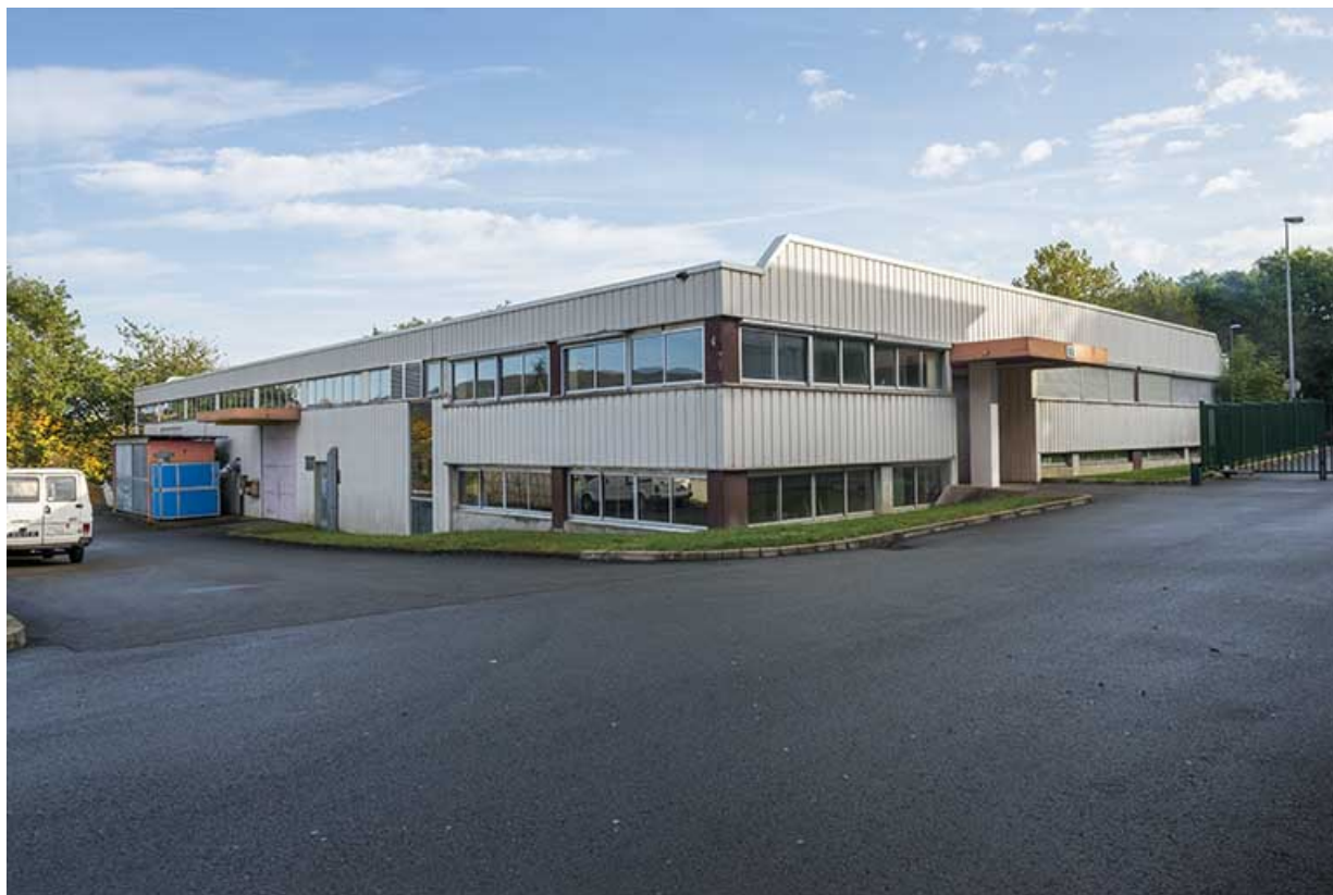
Angle sud-ouest de l'atelier de chaudronnerie et entrée nord-est.
