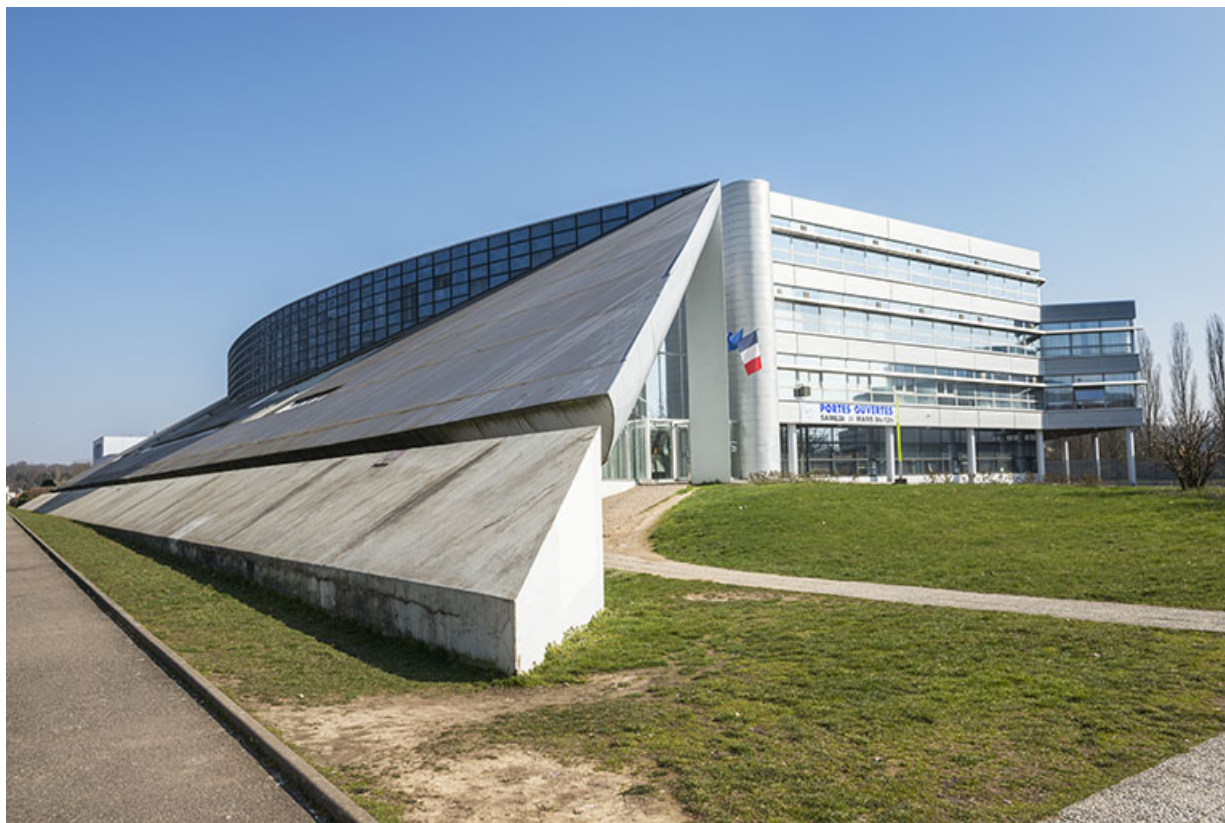
Lycée Gustave Courbet : façade d'entrée et angle nord-ouest du bâtiment socio-éducatif. 90, Belfort avenue du Général Gambiez
