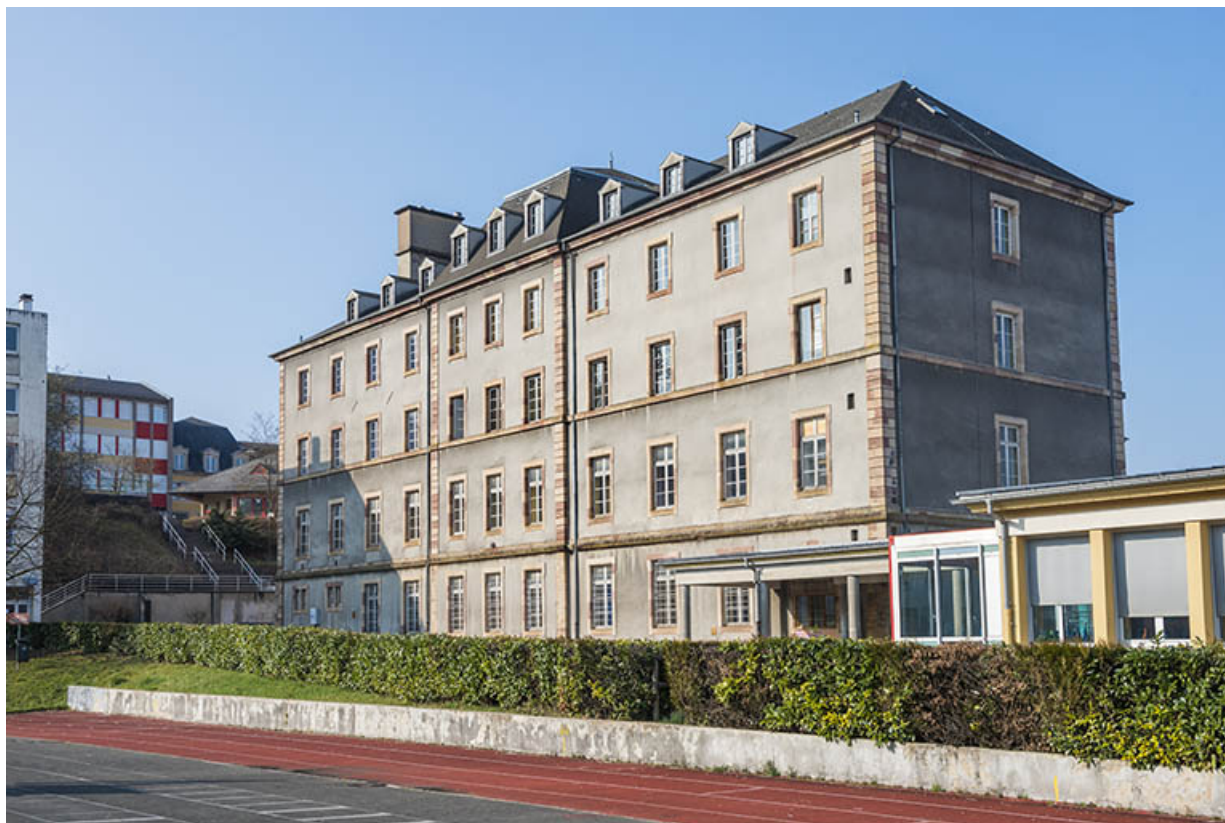
Stade, escalier jouxtant l'internat, angle sud-est du petit lycée.
