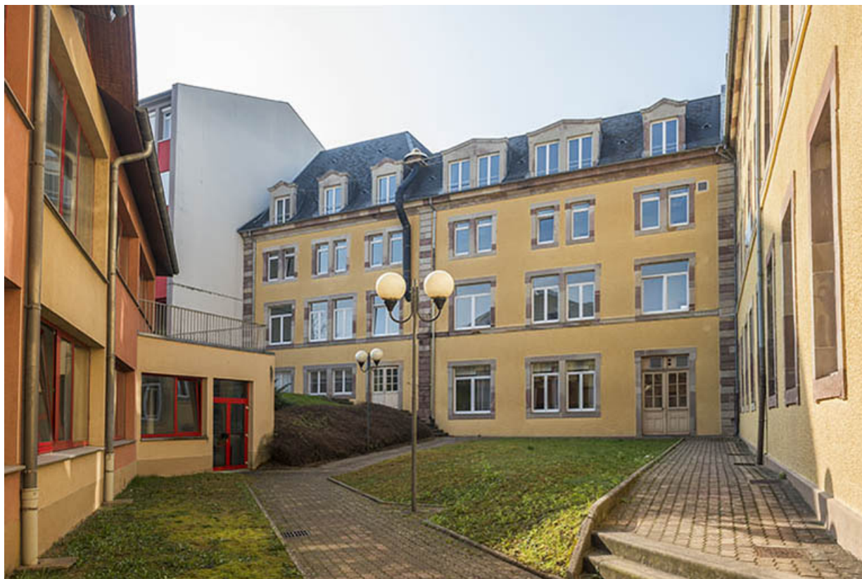
Cour derrière la façade postérieure sud du corps central du grand lycée.
