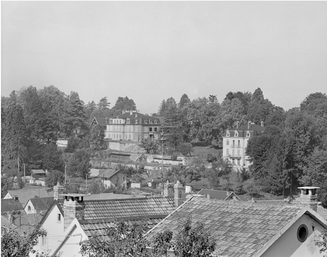
Vue d'ensemble depuis le sud-est (à gauche) en 1981. SRI. Enquête régionale sur les bâtiments industriels (1979-1981). 90, Beaucourt
