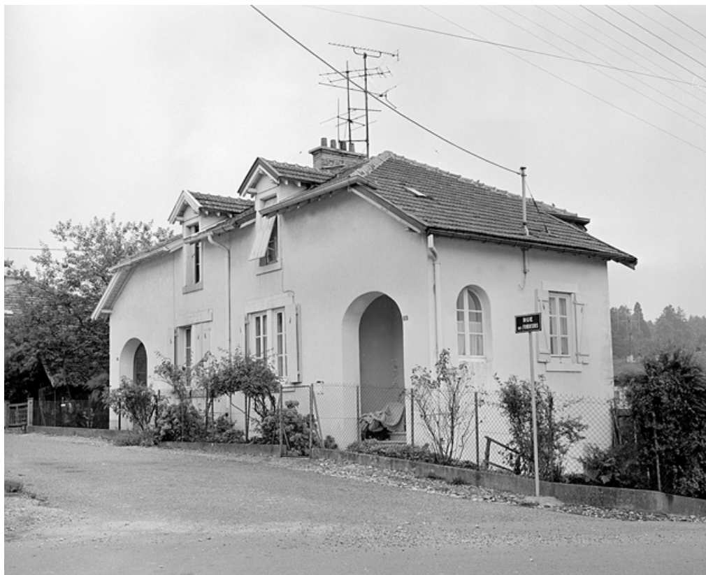
Maison jumelée rue des Fondateurs. SRI. Enquête régionale sur les bâtiments industriels (1979-1981). 90, Beaucourt, lieudit : cité Adolphe Japy
