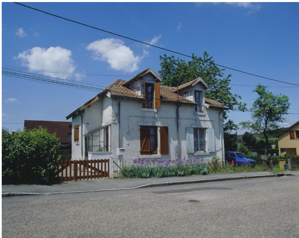
Maison jumelée à 2 travées : vue de trois quarts gauche.
