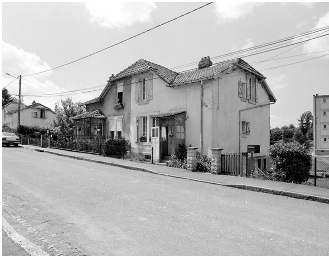
Maison jumelée rue de Normandie : vue de trois quarts droite.
