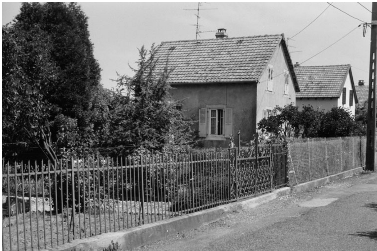
Maison (n° 3) de la rue n° 1 de la cité Bellevue. SRI. Inventaire topographique du canton de Beaucourt (1981-1982). 90, Beaucourt, lieudit : cité Bellevue
