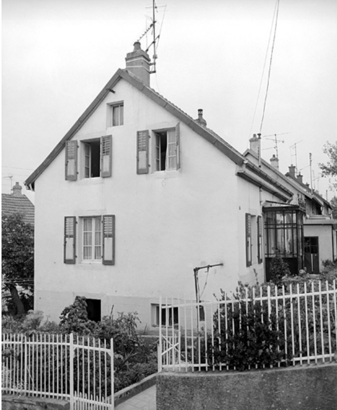
Maison individuelle rue du Réveille-matin : vue de face. SRI. Enquête régionale sur les bâtiments industriels (1979-1981). 90, Beaucourt, lieudit : cité du Chatelot
