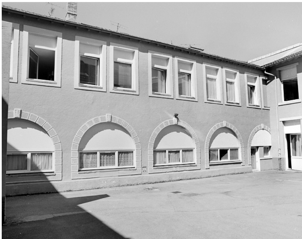
Élévation (remaniée) d'un atelier de fabrication depuis la cour.
