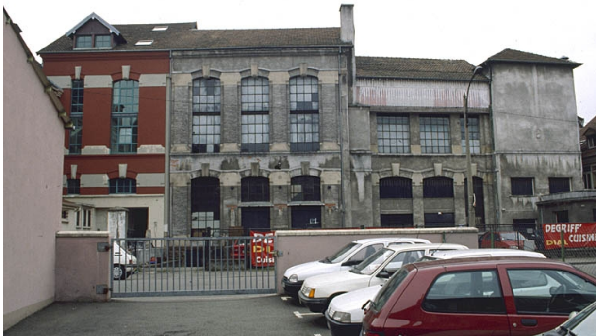
Façade antérieure de l'atelier de fabrication.
