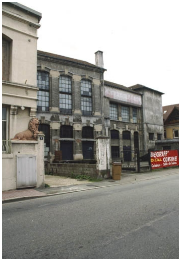
Vue de trois quarts gauche de la façade de l'atelier de fabrication.
