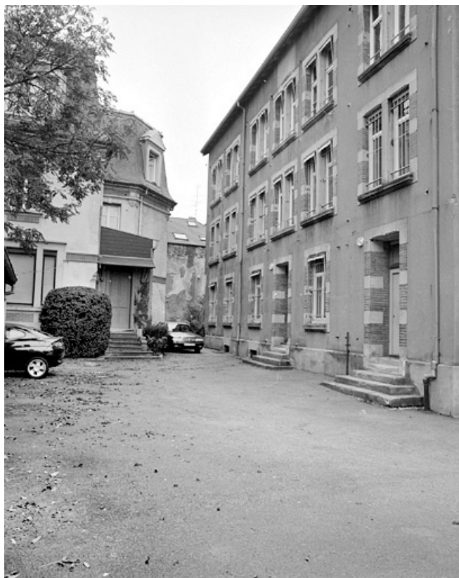
Façade postérieure du bâtiment situé au n° 25.
