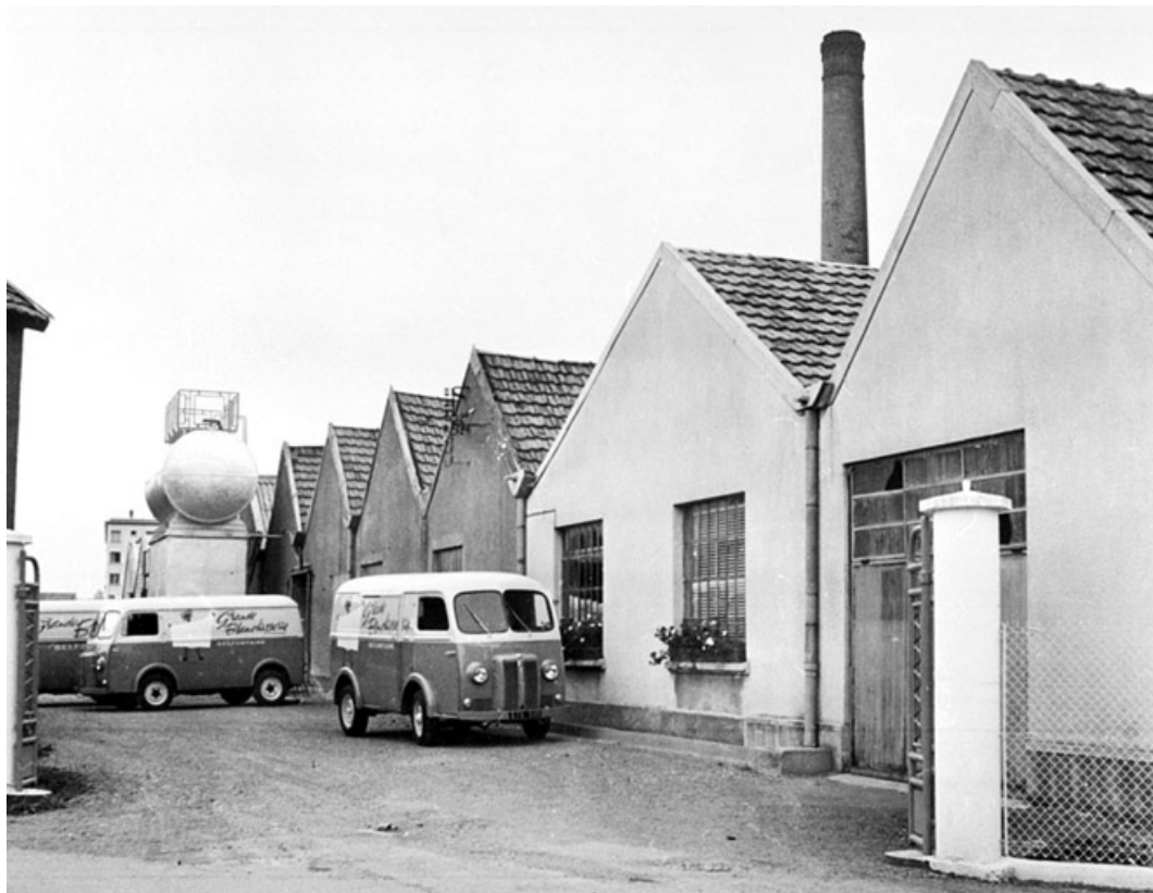
Pignons ouest des ateliers depuis l'entrée.
