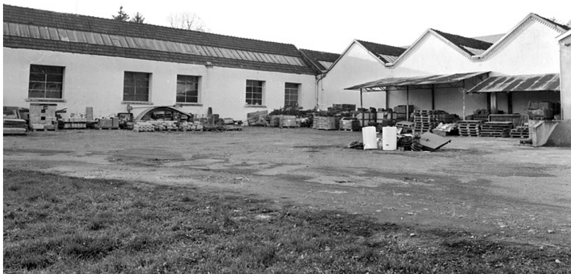
Façades arrière depuis la cour.
