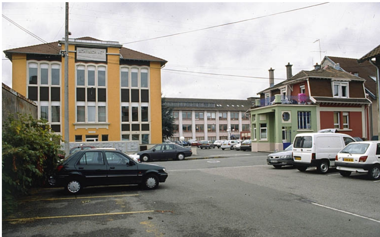
Vue de l'entrée depuis le nord.
