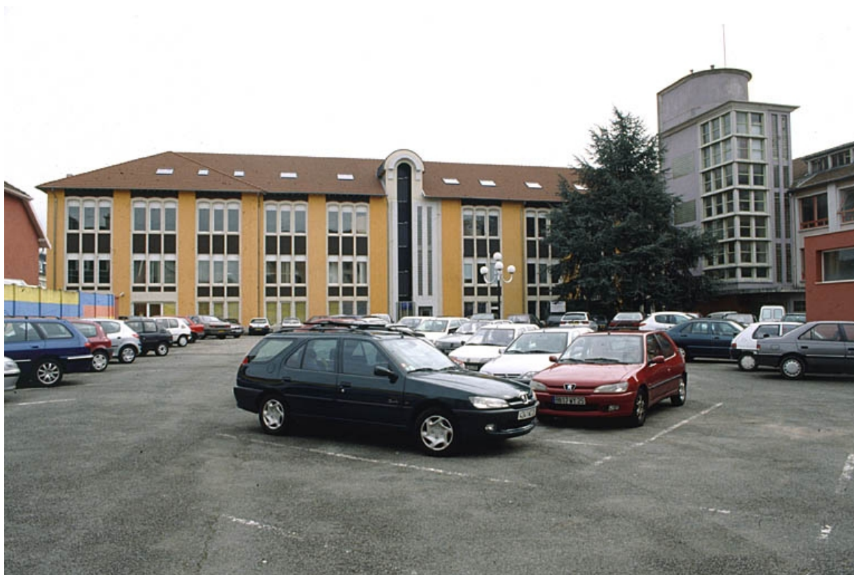
Façade ouest de l'atelier depuis la cour.
