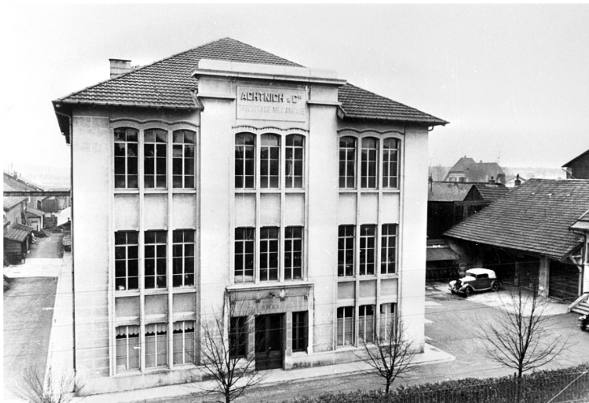
Façade nord de l'usine.
