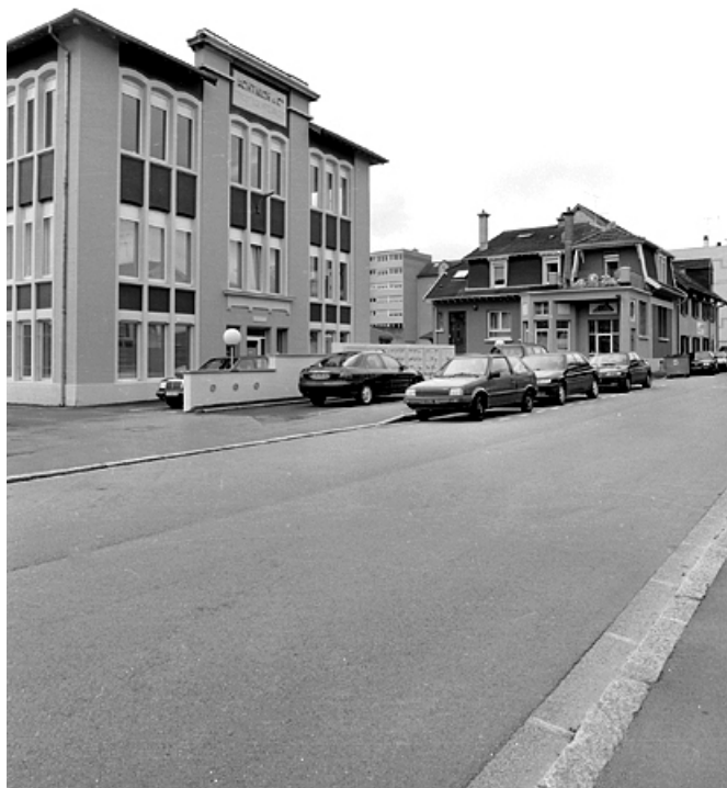
Façade nord de l'atelier de fabrication et conciergerie.
