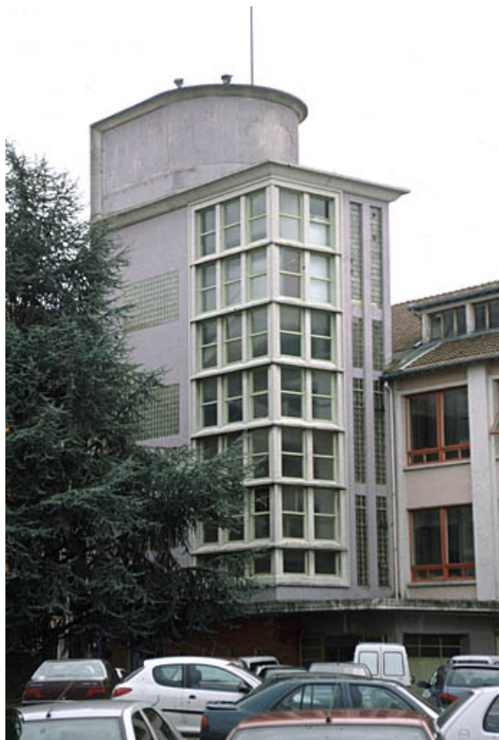
Escalier hors-oeuvre construit à la jonction des deux ateliers.
