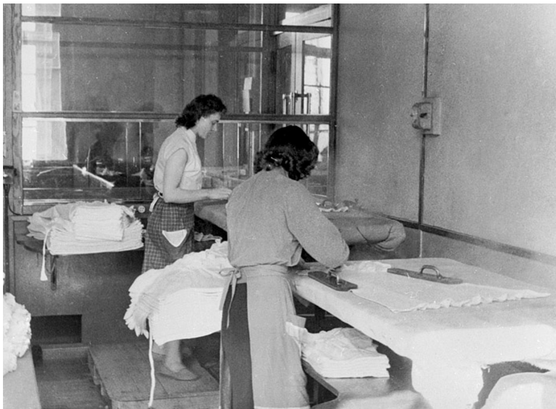
Vue d'un atelier de vaporisation et repassage.
