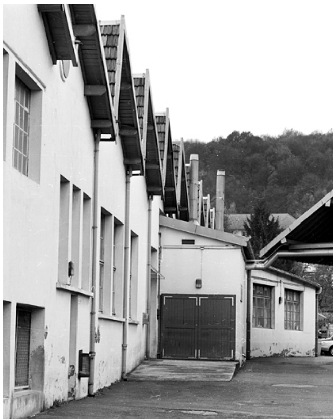
Détail de l'alignement nord de l'ancien atelier de fabrication.
