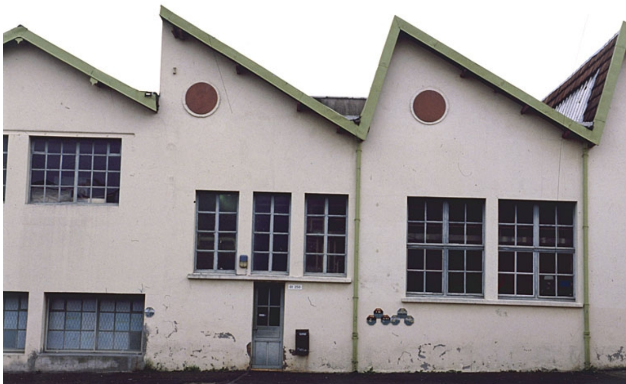
Détail des pignons nord de l'ancien atelier de fabrication.
