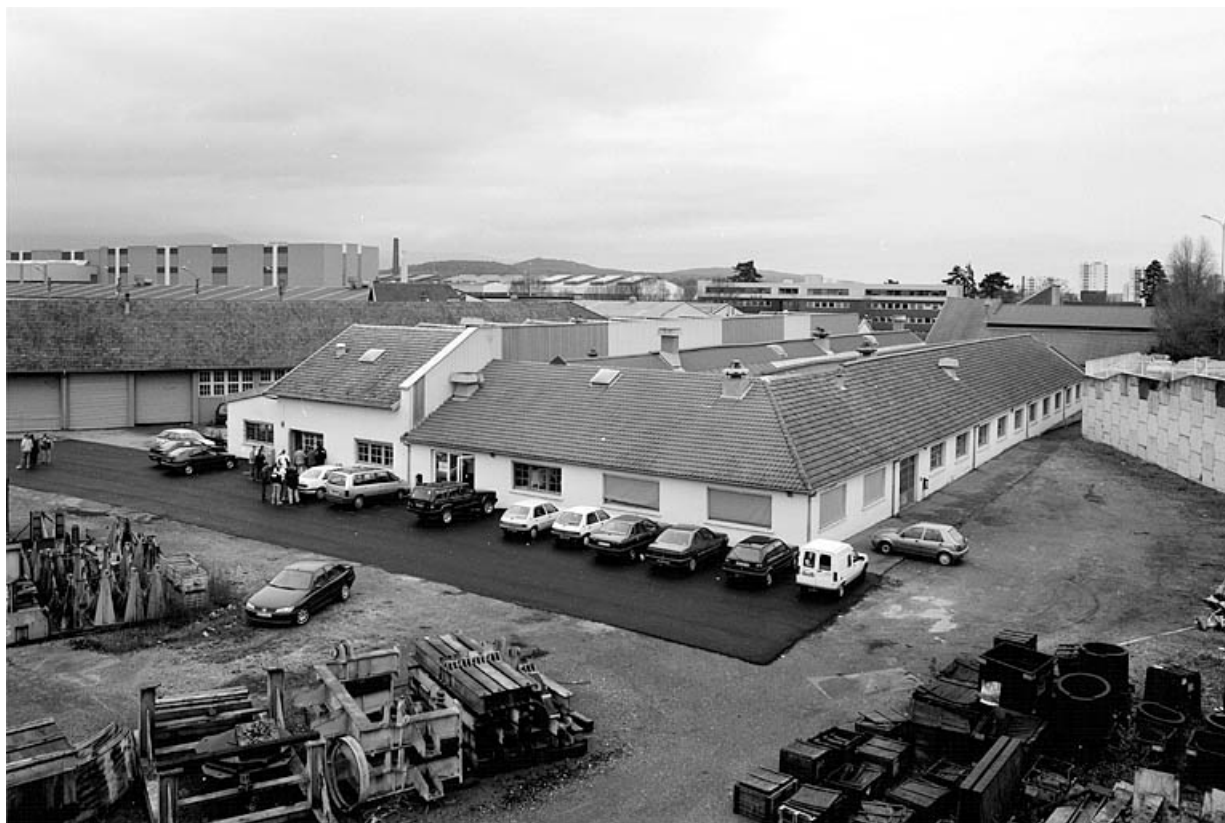
Vue d'ensemble depuis le sud-ouest. 90, Belfort, 3 rue de Soissons
