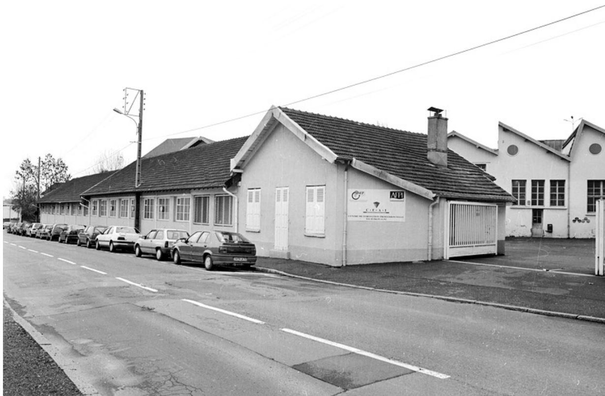
Vue des bâtiments est depuis la rue de Soissons.
