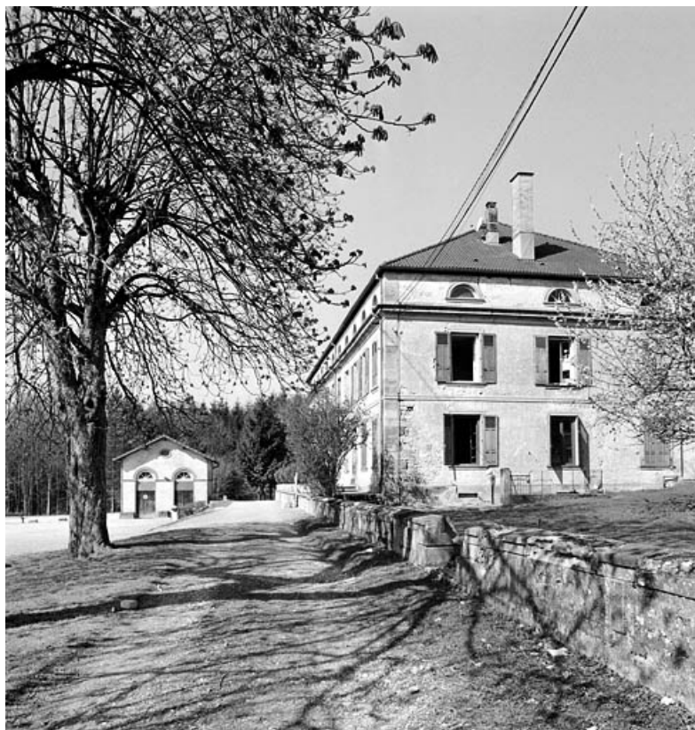
Façades est de la salle des machines et de l'atelier de fabrication.
