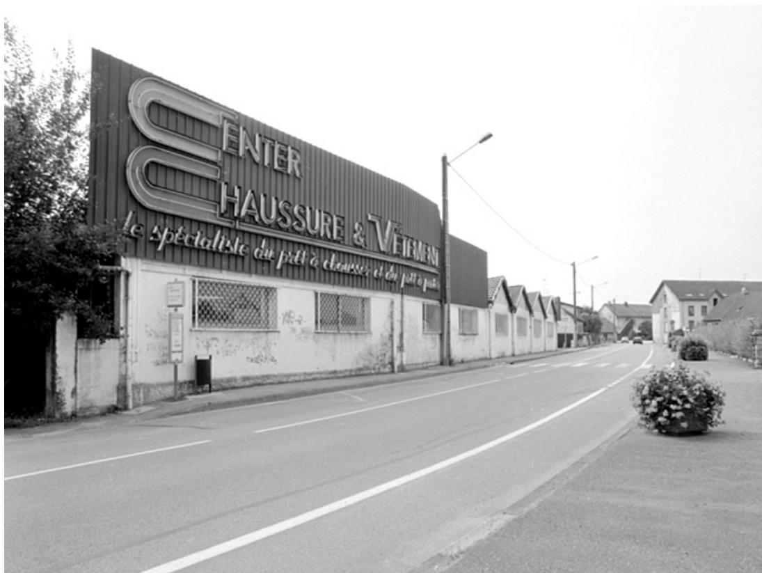
Vue d'ensemble depuis le nord. 90, Valdoie, 4 avenue Oscar Ehret
