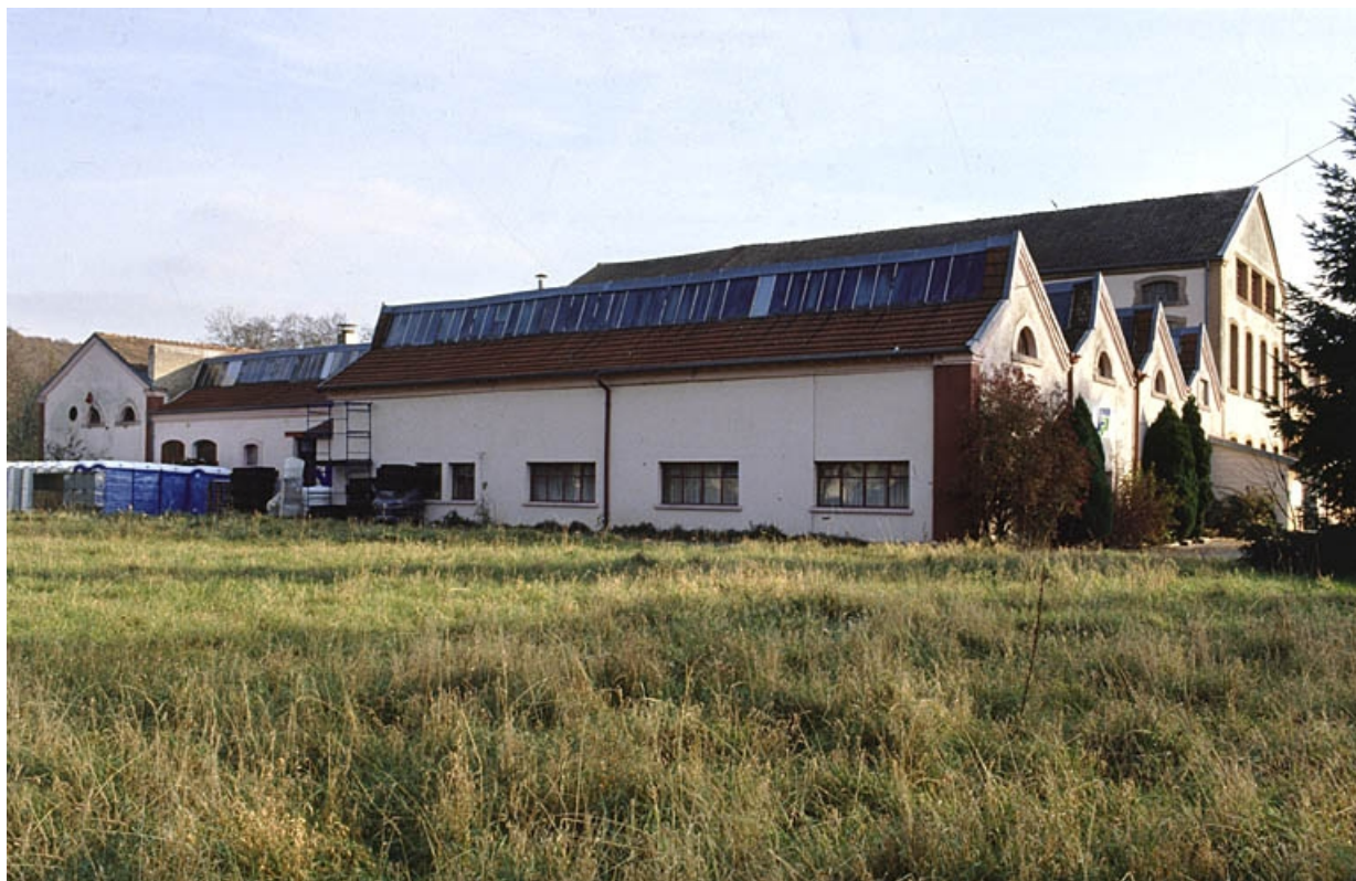
Vue de trois quarts depuis l'ouest.
