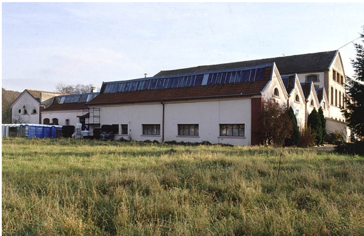
Vue de trois quarts depuis l'ouest.
