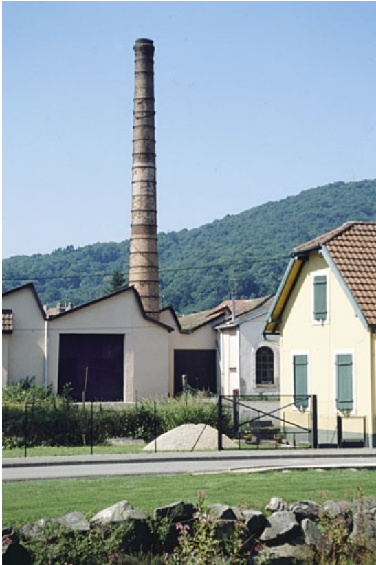
Ateliers de fabrication et cheminée depuis l'est.
