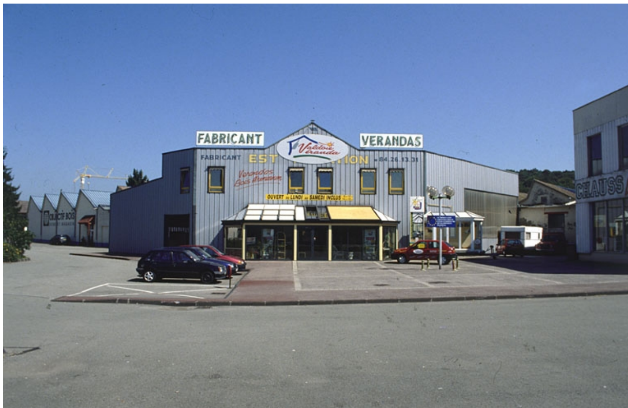
Vue depuis le sud-ouest. Rhabillage des anciennes façades.
