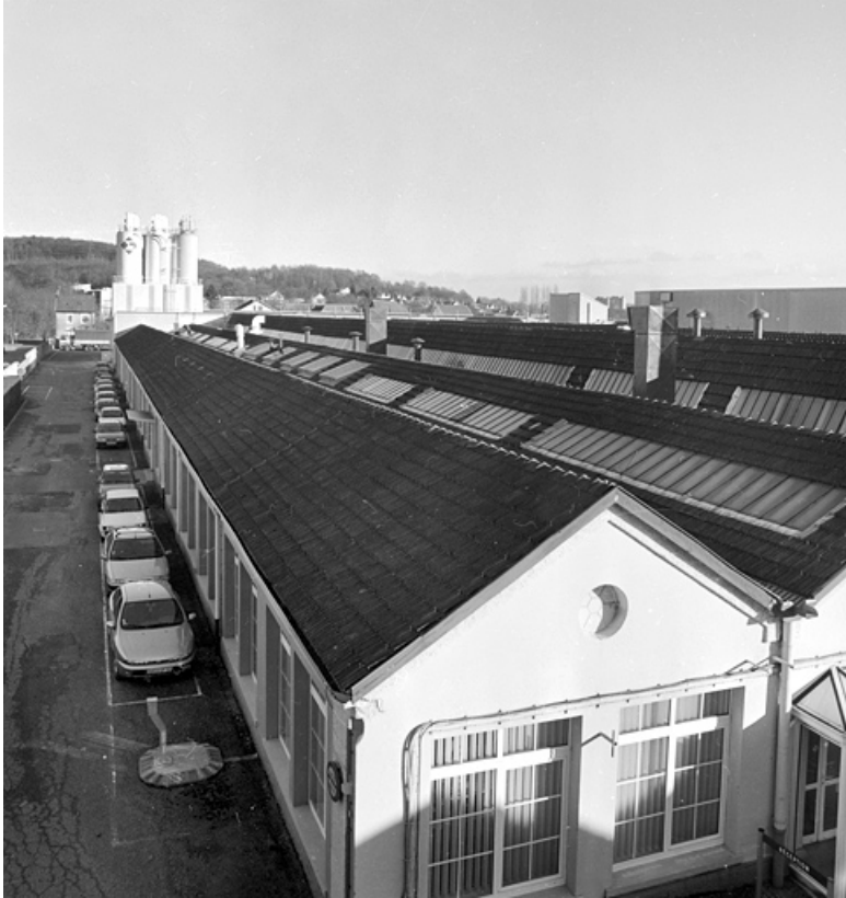
Vue plongeante sur les travées nord des ateliers de fabrication.
