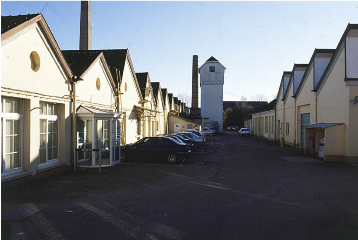
Ateliers de fabrication, cheminée, réservoir industriel et magasins industriels depuis le nord. 90, Valdoie, 2 rue Jean Jaurès
