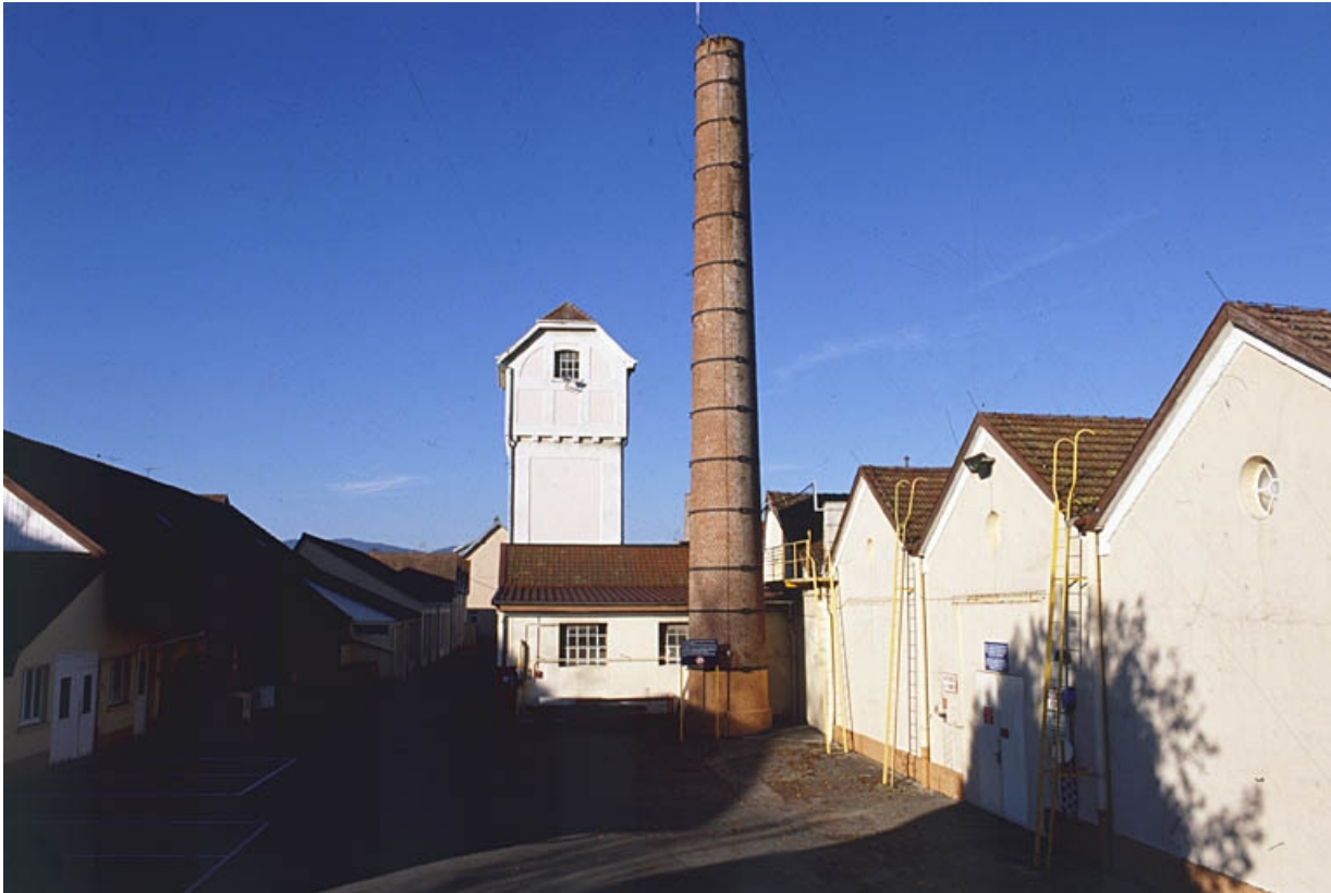
Vue d'ensemble depuis le sud : magasin industriel, réservoir industriel, cheminée et entrepôt industriel. 90, Valdoie, 2 rue Jean Jaurès
