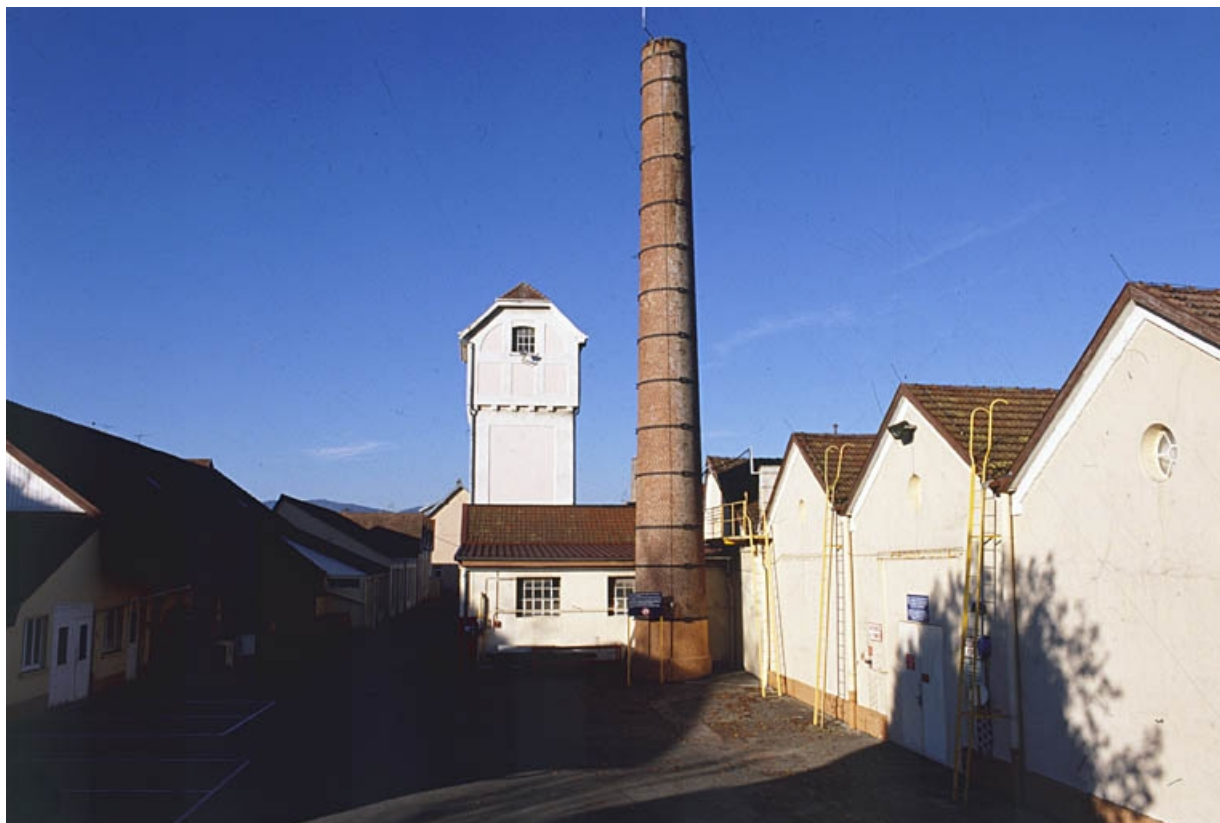
Vue d'ensemble depuis le sud : magasin industriel, réservoir industriel, cheminée et entrepôt industriel.
