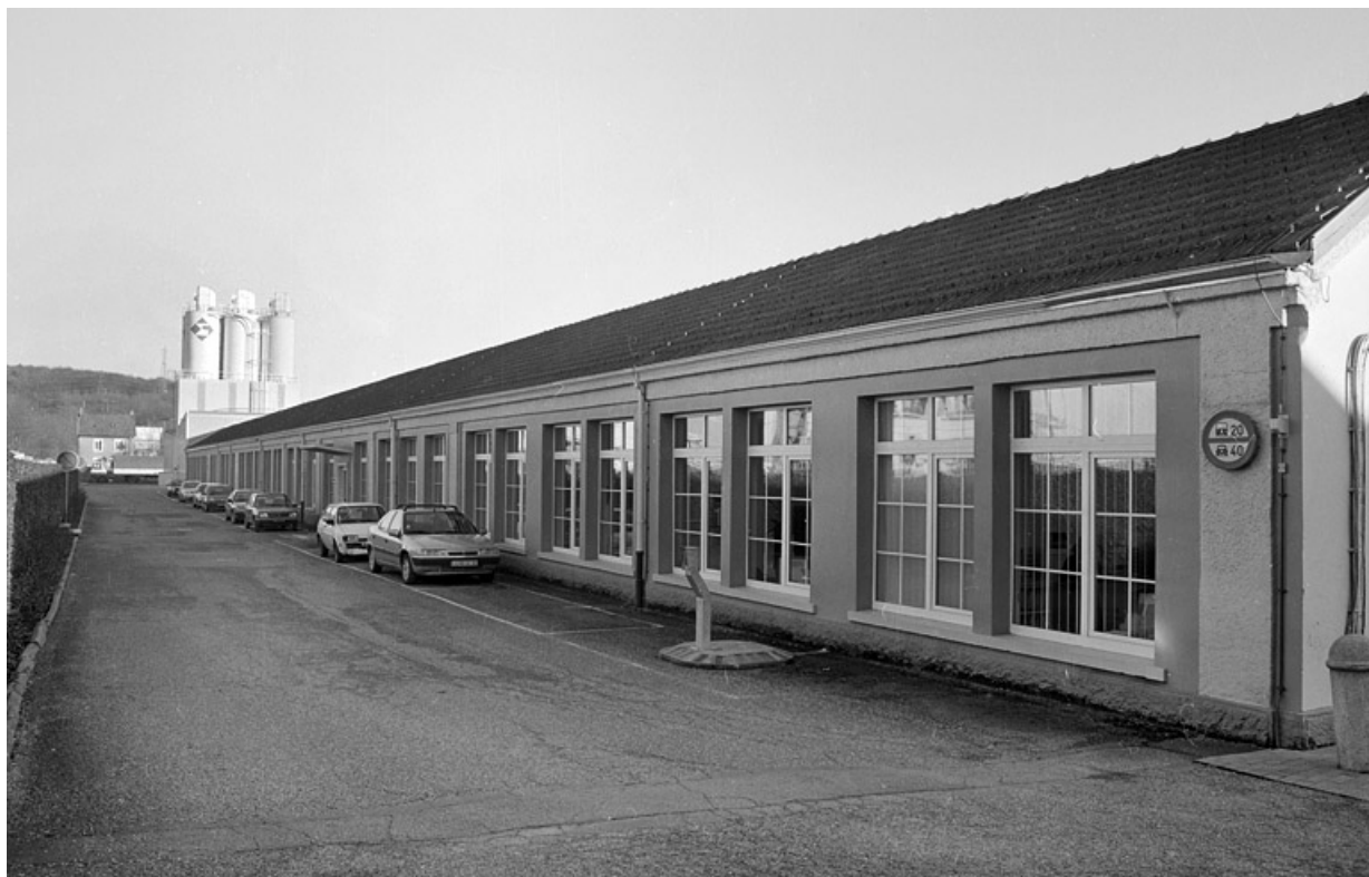
Façade nord de l'atelier de fabrication.
