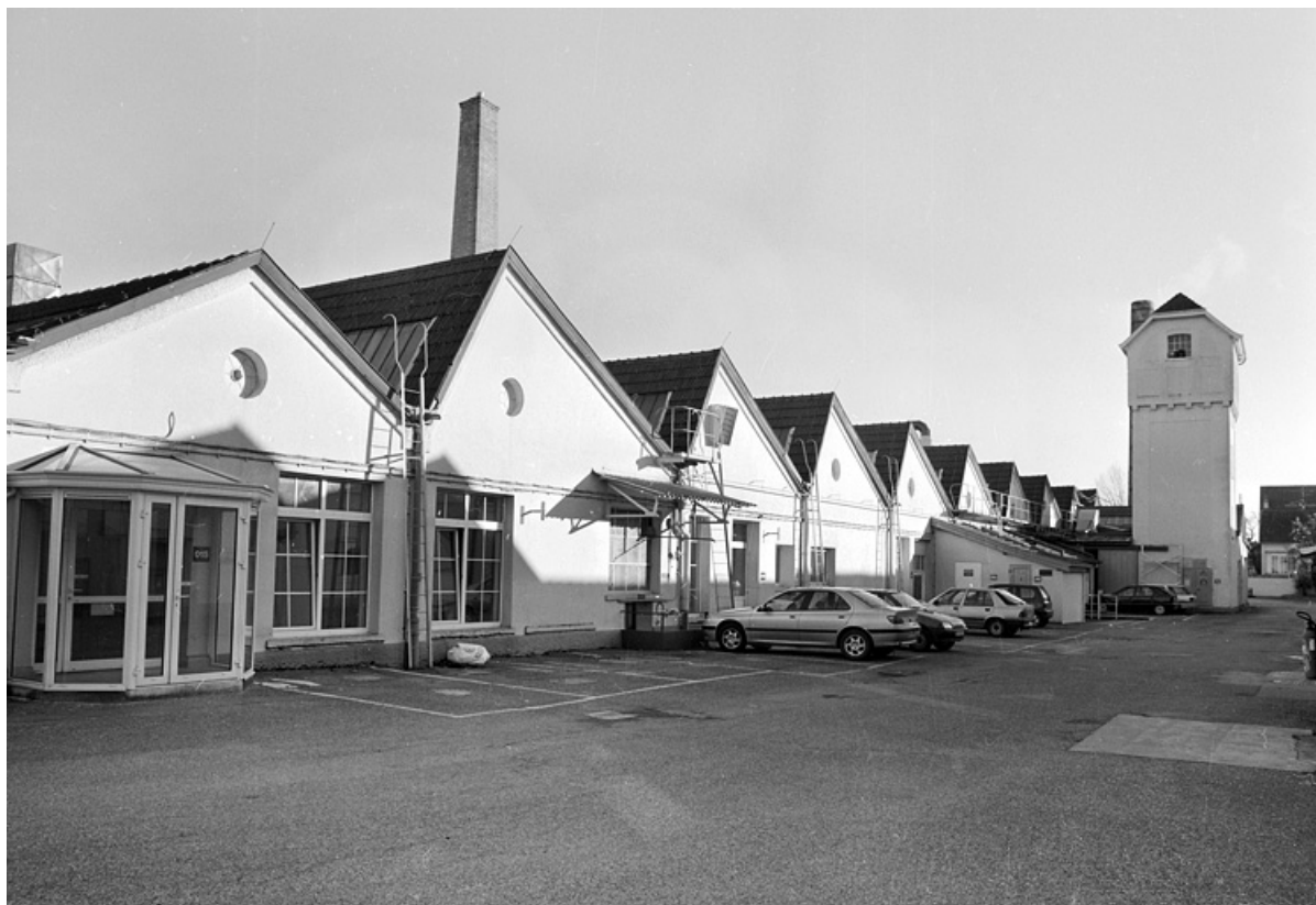
Pignons ouest de l'atelier de fabrication.
