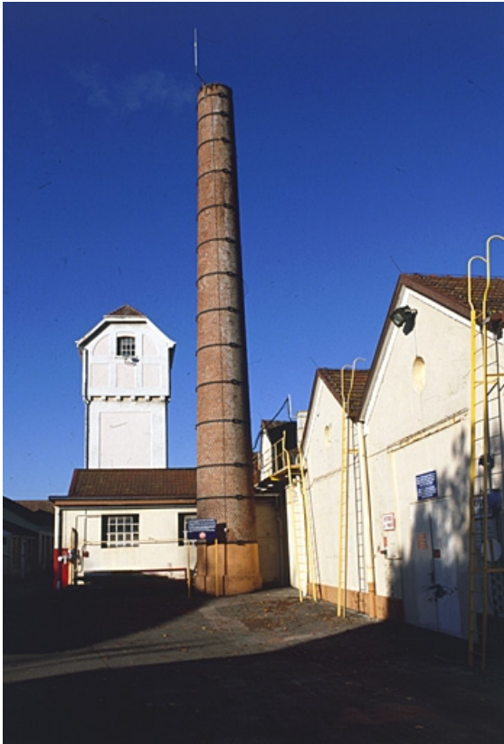
Réservoir industriel, cheminée et entrepôt industriel.
