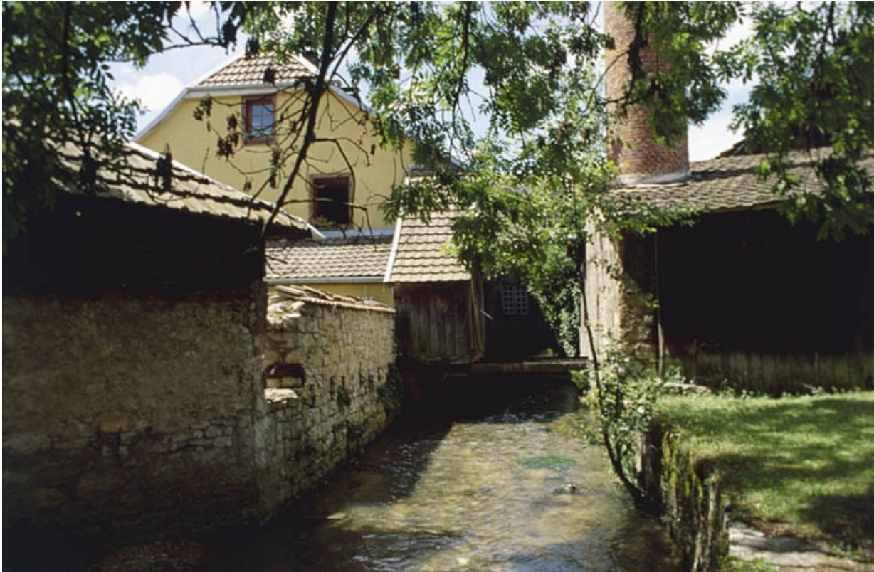
Vue en aval de la Batte.
