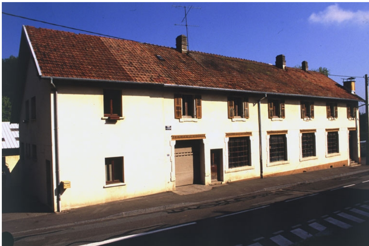
Façade sur rue de l'atelier de fabrication.
