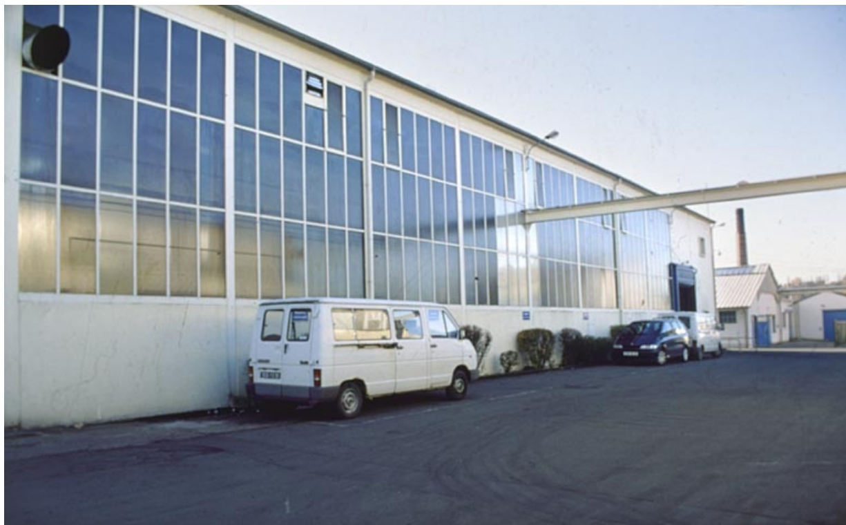
Façade vitrée de l'atelier de traitement de surface.
