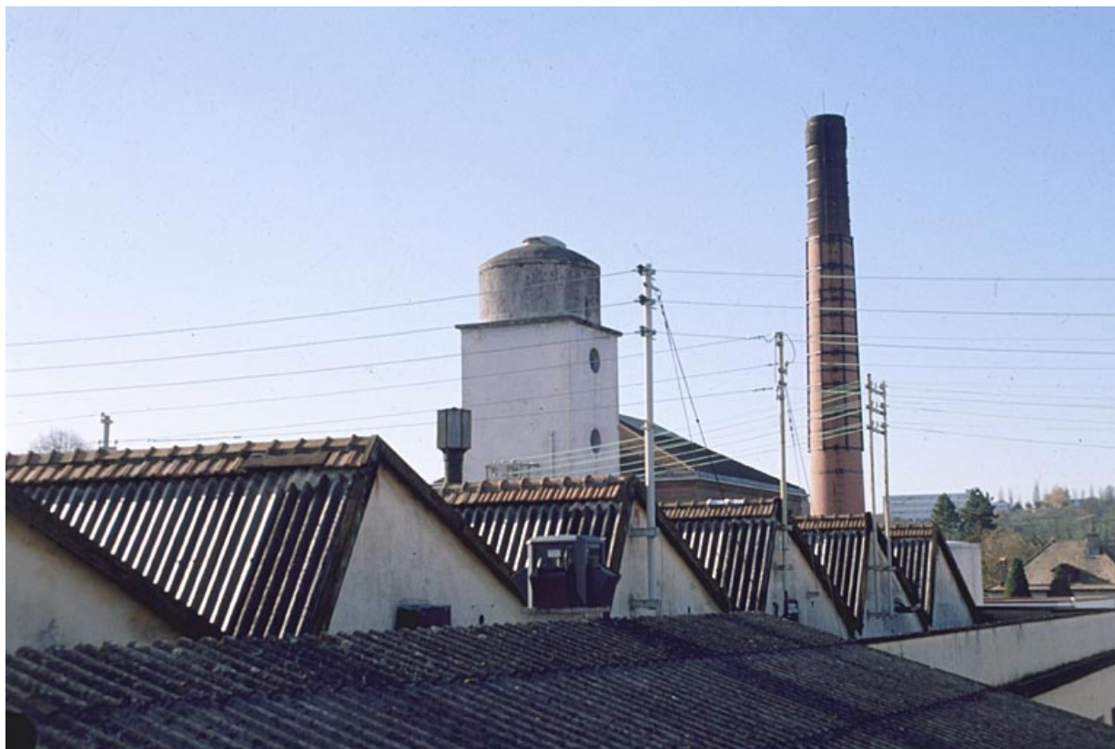
Toiture des ateliers de fabrication, château d'eau et cheminée.
