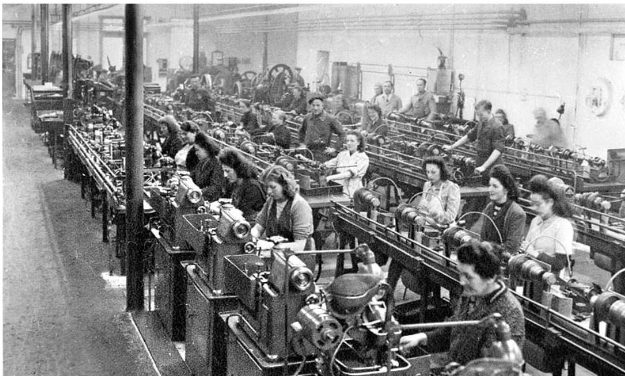
Atelier de reprises : batteries de petites machines.
