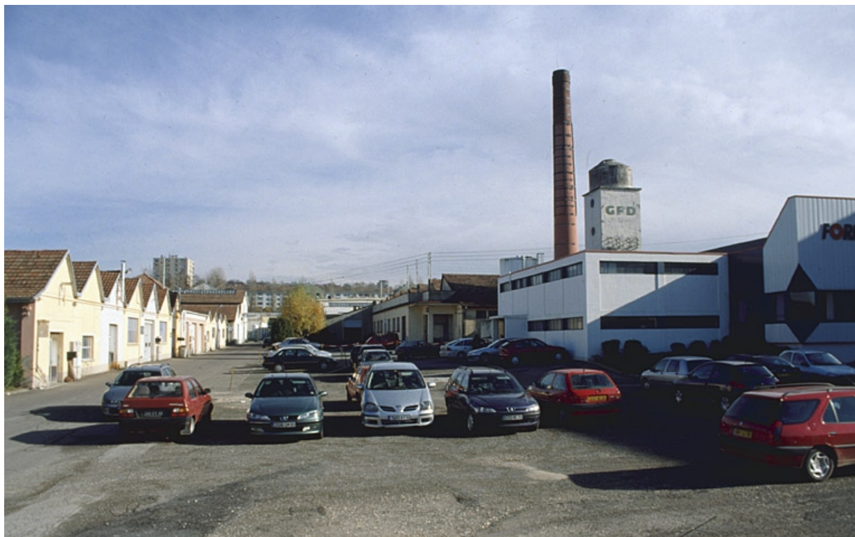
Vue d'ensemble depuis l'entrée.
