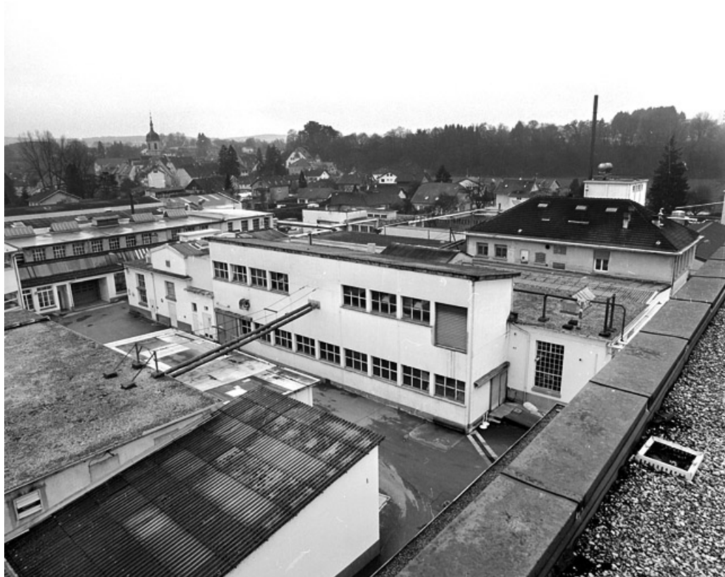
Vue plongeante vers le sud-ouest.
