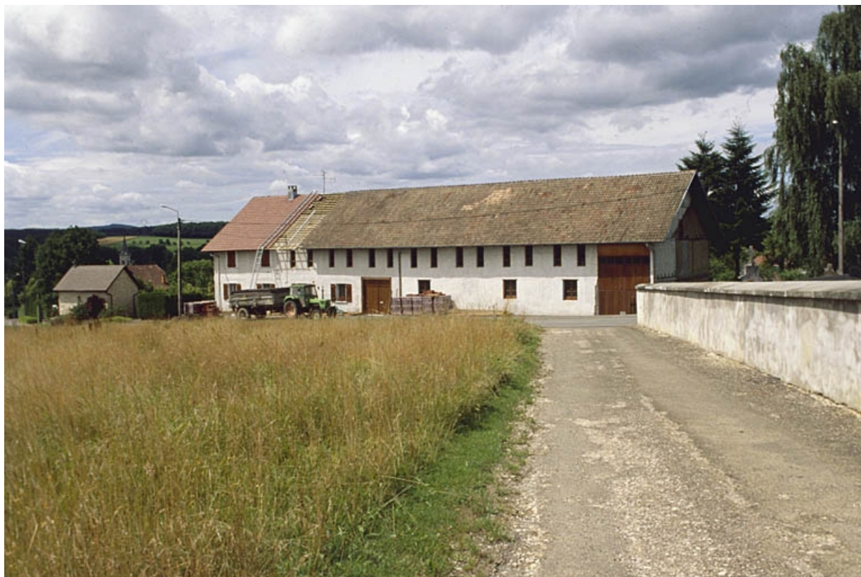
Façade est de l'atelier de fabrication.
