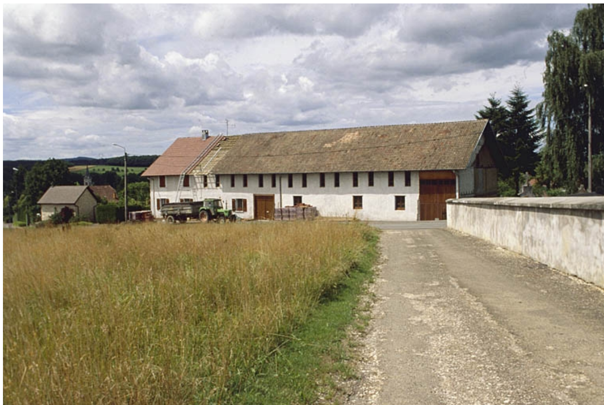
Façade est de l'atelier de fabrication.
