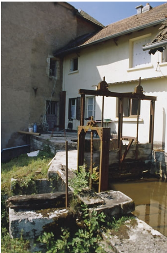
Vannage sur le canal d'amenée.
