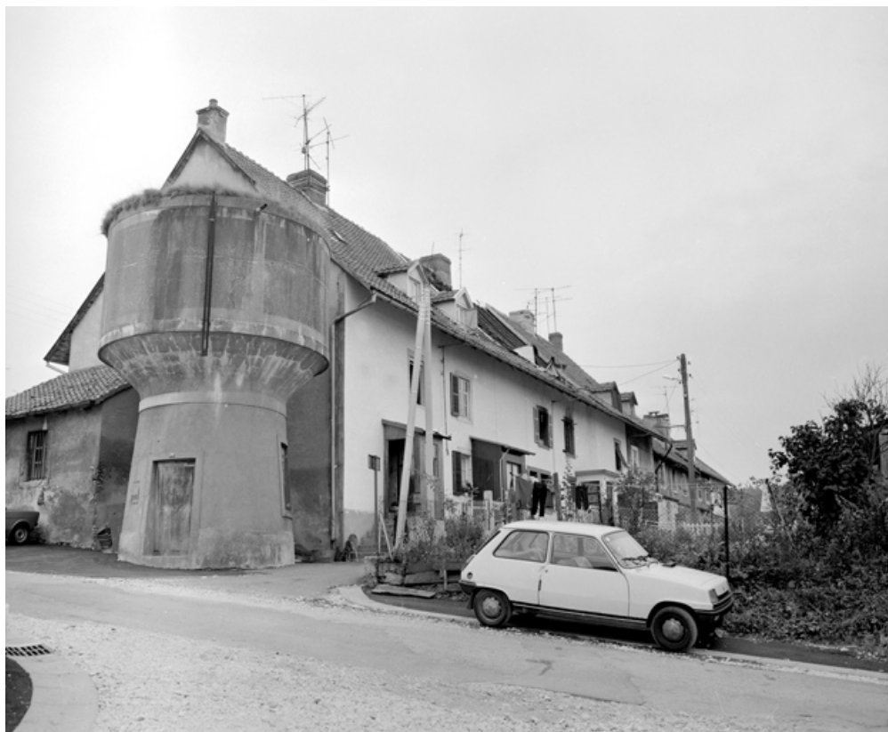
"Caserna" rue des Bouleaux : vue depuis le nord en 1981. SRI. Enquête régionale sur les bâtiments industriels (1979-1981). 90, Beaucourt, lieudit : cité Pierre Japy
