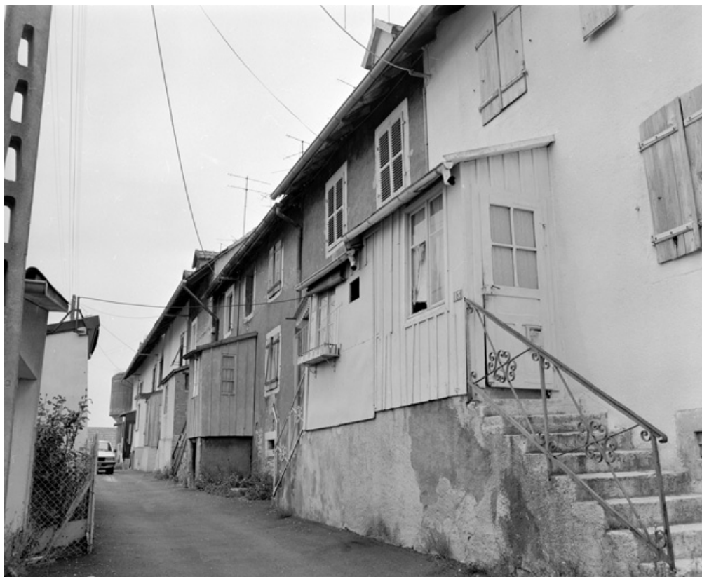
"Casernes" rue des Bouleaux : vue depuis le sud en 1981. SRI. Enquête régionale sur les bâtiments industriels (1979-1981). 90, Beaucourt, lieudit : cité Pierre Japy
