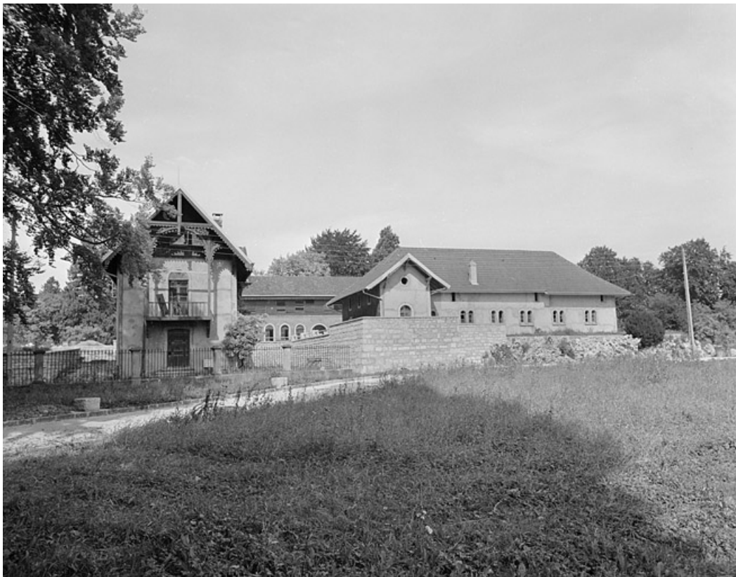
Bâtiments agricoles depuis le sud en 1981. SRI. Enquête régionale sur les bâtiments industriels (1979-1981). 90, Beaucourt rue Sous les Vignes
