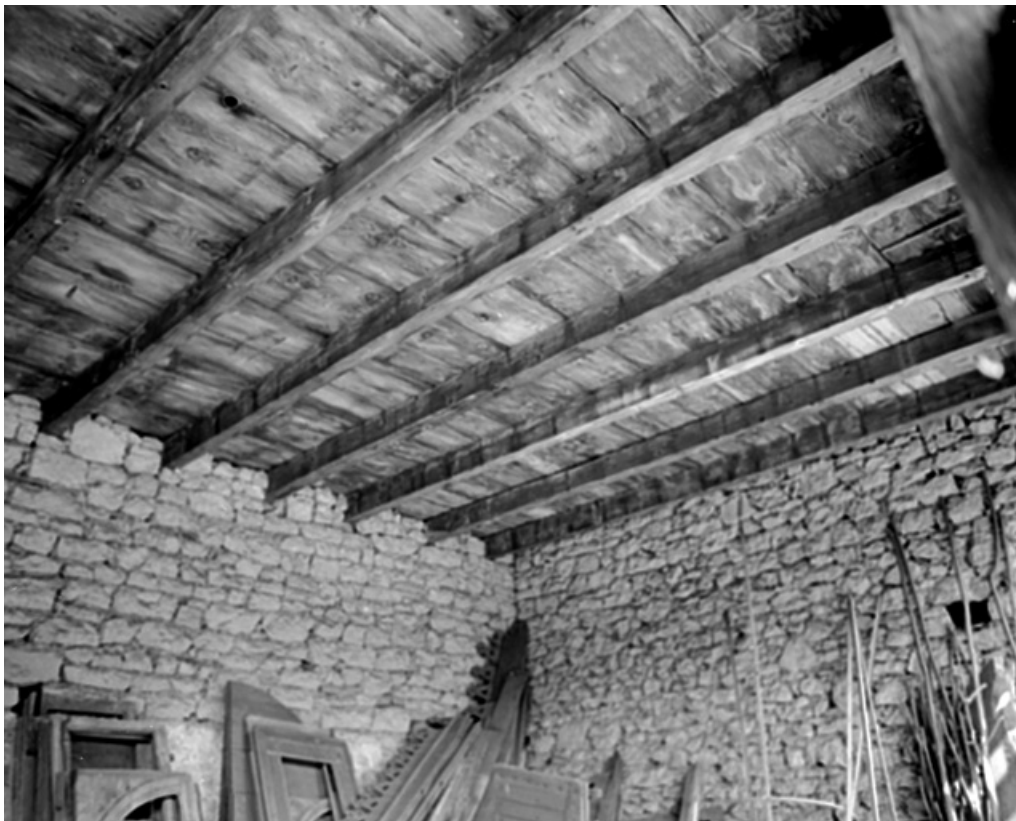
Intérieur de l'orangerie en 1981. SRI. Inventaire topographique du canton de Beaucourt (1981-1982). 90, Beaucourt rue Sous les Vignes
