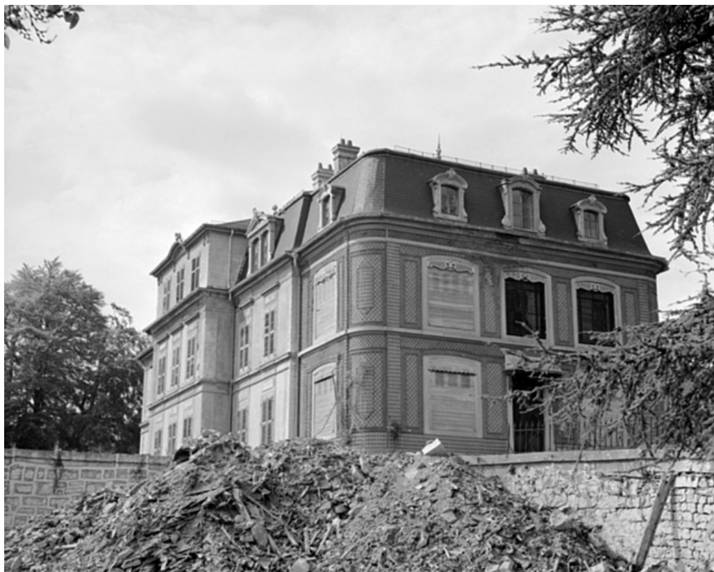
Façades sud et nord vues de trois quarts en 1981. SRI. Enquête régionale sur les bâtiments industriels (1979-1981). 90, Beaucourt rue Sous les Vignes
