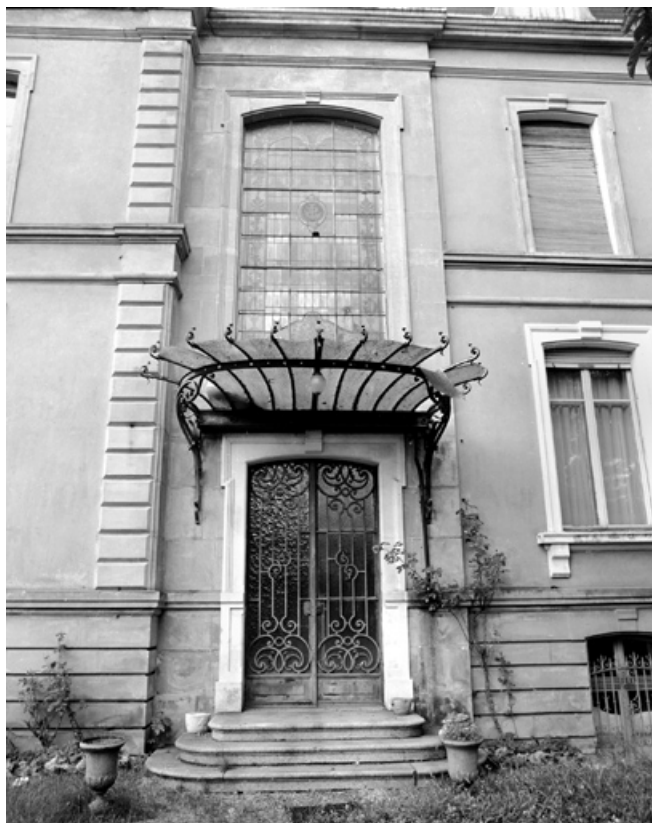
Façade est : détail de la porte en 1981. SRI. Enquête régionale sur les bâtiments industriels (1979-1981). 90, Beaucourt avenue des Vignes
