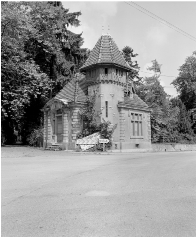
Conciergerie en 1981. SRI. Enquête régionale sur les bâtiments industriels (1979-1981). 90, Beaucourt parc des Cèdres
