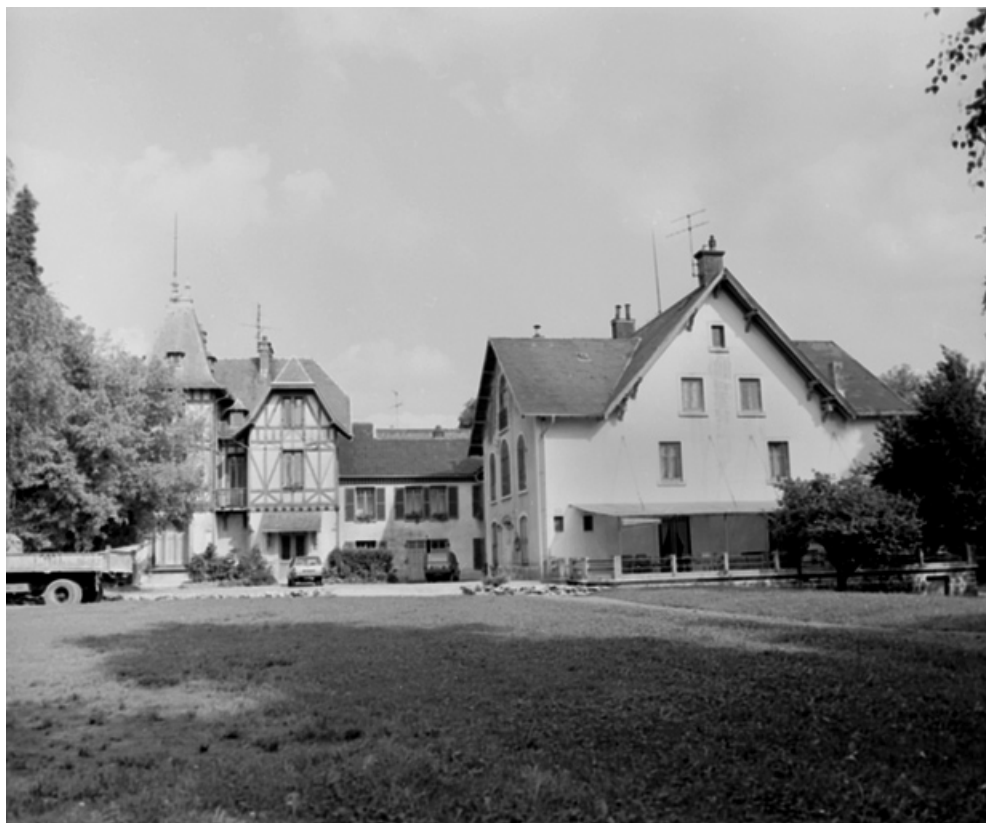
Vue d'ensemble depuis l'ouest en 1981. SRI. Enquête régionale sur les bâtiments industriels (1979-1981). 90, Beaucourt, 1, 3 rue du Mont de Dasle
