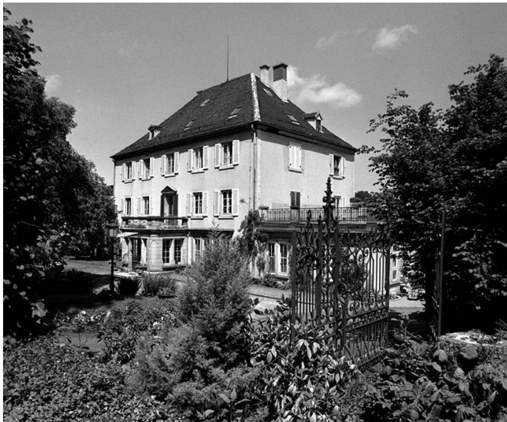
Vue de trois quarts depuis le sud-est.
