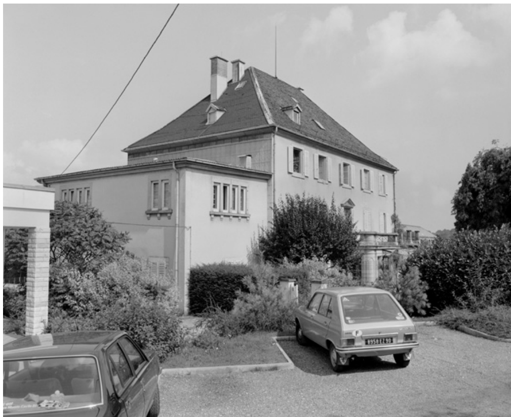
Façade postérieure en 1981. SRI. Enquête régionale sur les bâtiments industriels (1979-1981). 90, Beaucourt, 7 rue Frédéric Japy
