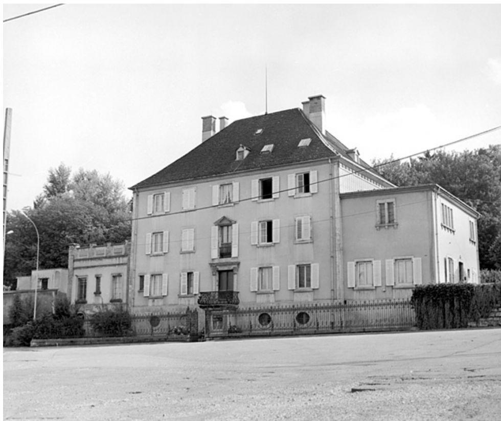
Façade sur rue en 1981. SRI. Enquête régionale sur les bâtiments industriels (1979-1981). 90, Beaucourt, 7 rue Frédéric Japy
