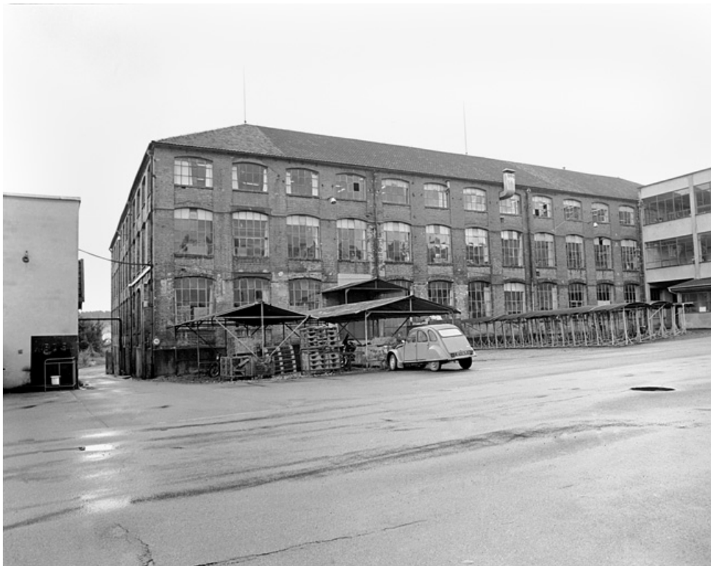
Façade postérieure du bâtiment sur la cour dite du Fer à cheval en 1981. SRI. Enquête régionale sur les bâtiments industriels (1979-1981).
