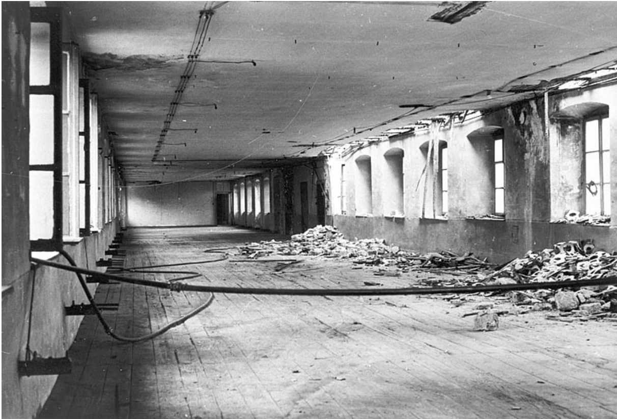
Atelier au second étage (état en 1978).
