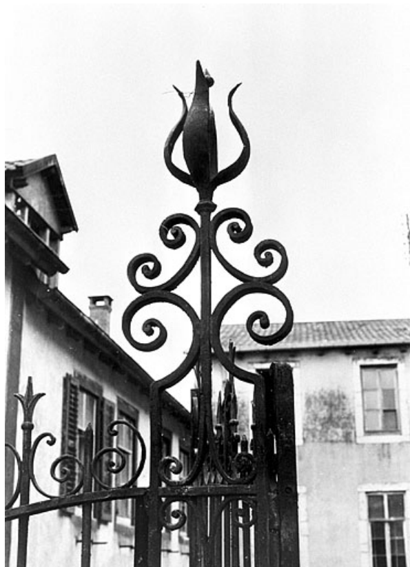
Bâtiments ouest : détail de la grille (état en 1978).
