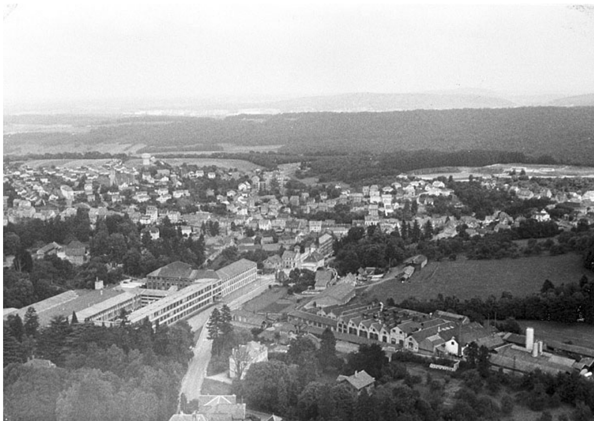
Vue aérienne depuis le sud-ouest en 1982. 90, Beaucourt
