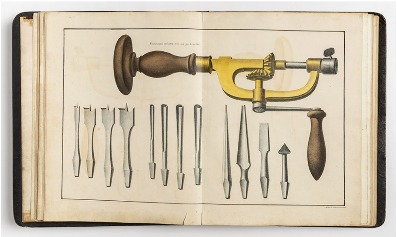
Vilebrequin en laiton avec son jeu de mèches [planche de catalogue], 1835.
