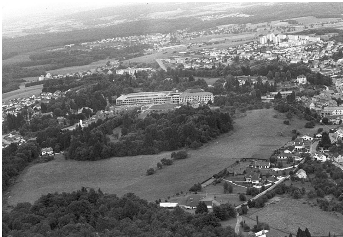
Vue aérienne générale depuis le sud en 1982. 90, Beaucourt
