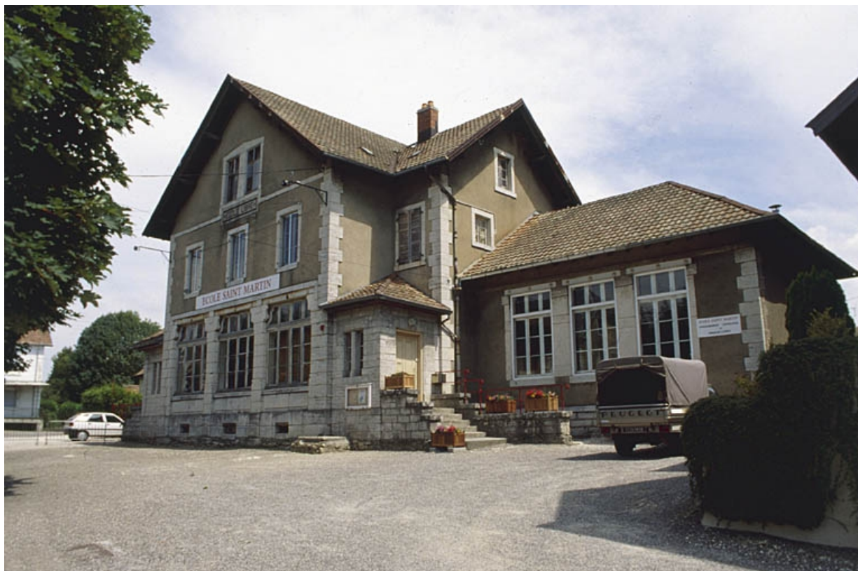
Façade antérieure depuis l'ouest.
