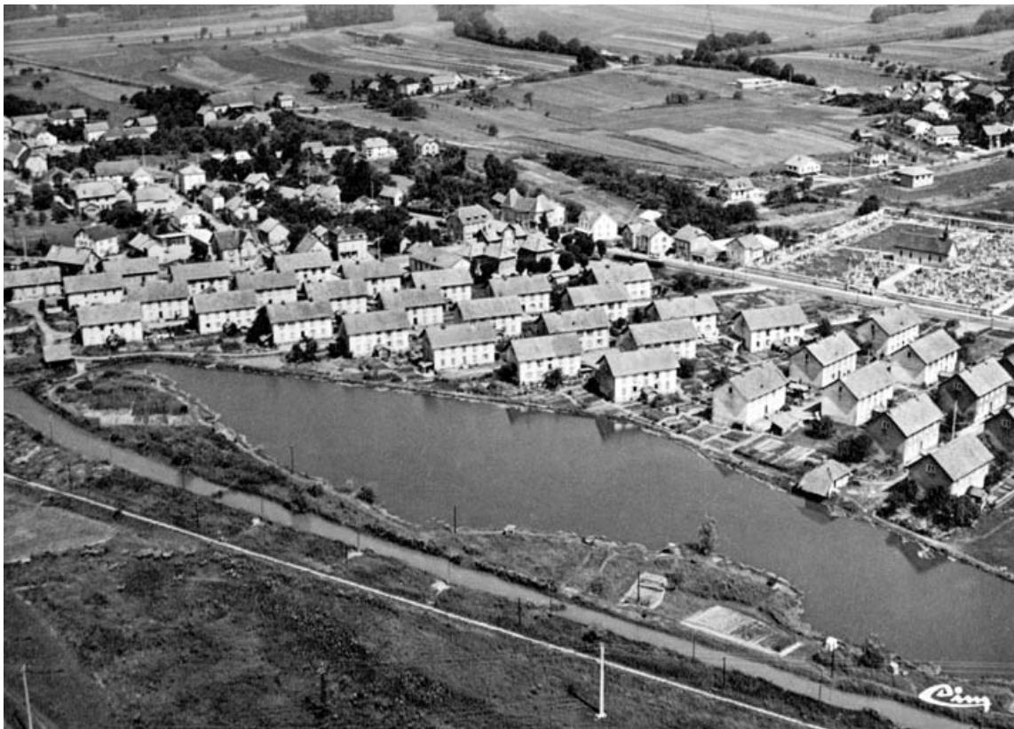
Grandvillars. (T.-de-B.). Vue générale aérienne.
