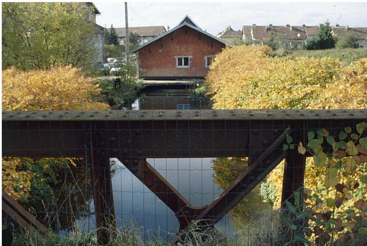
Passerelle sur le canal d'aménée.
