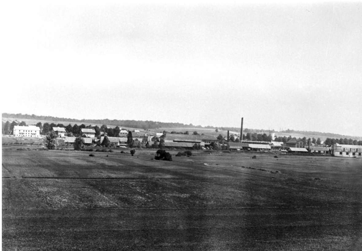
Les Forges de Grandvillars depuis l'ouest.
