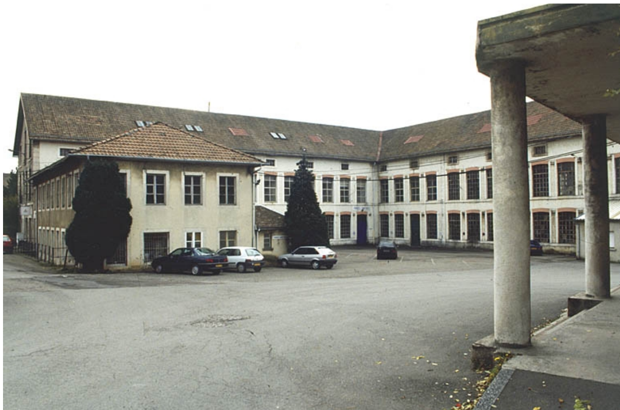
La cour de l'usine depuis l'entrée.
