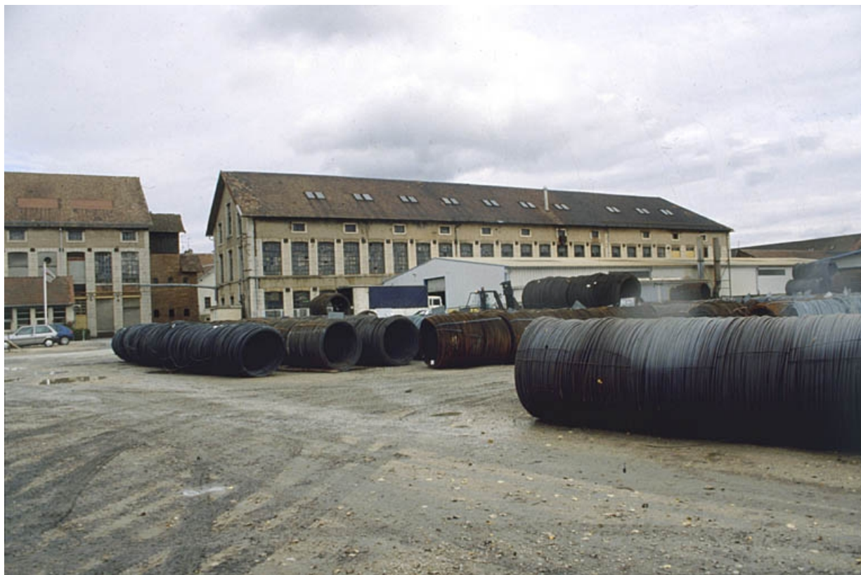
Ateliers de fabrication et aire des matières premières (parc à fil).
