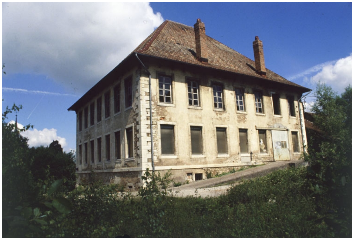
Vue de trois quarts arrière du château.
