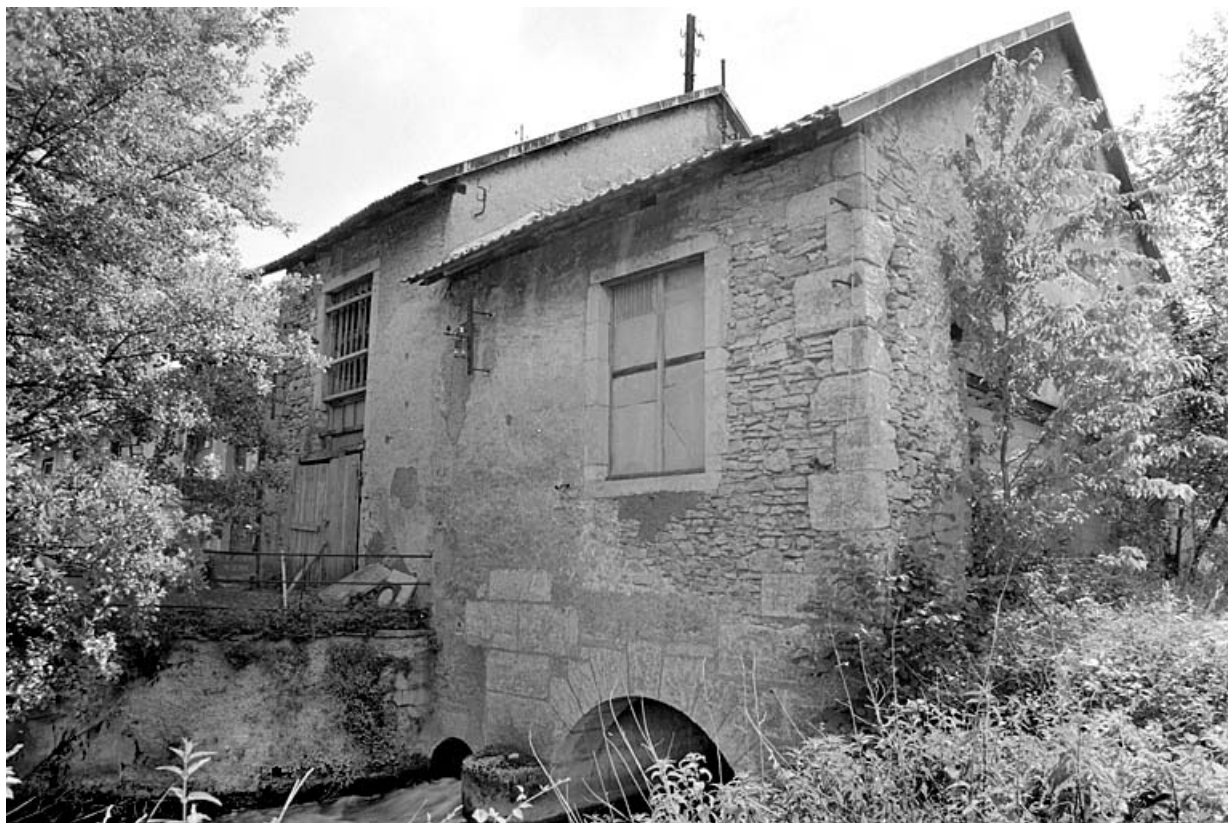
Salle des machines et bâtiment d'eau.
