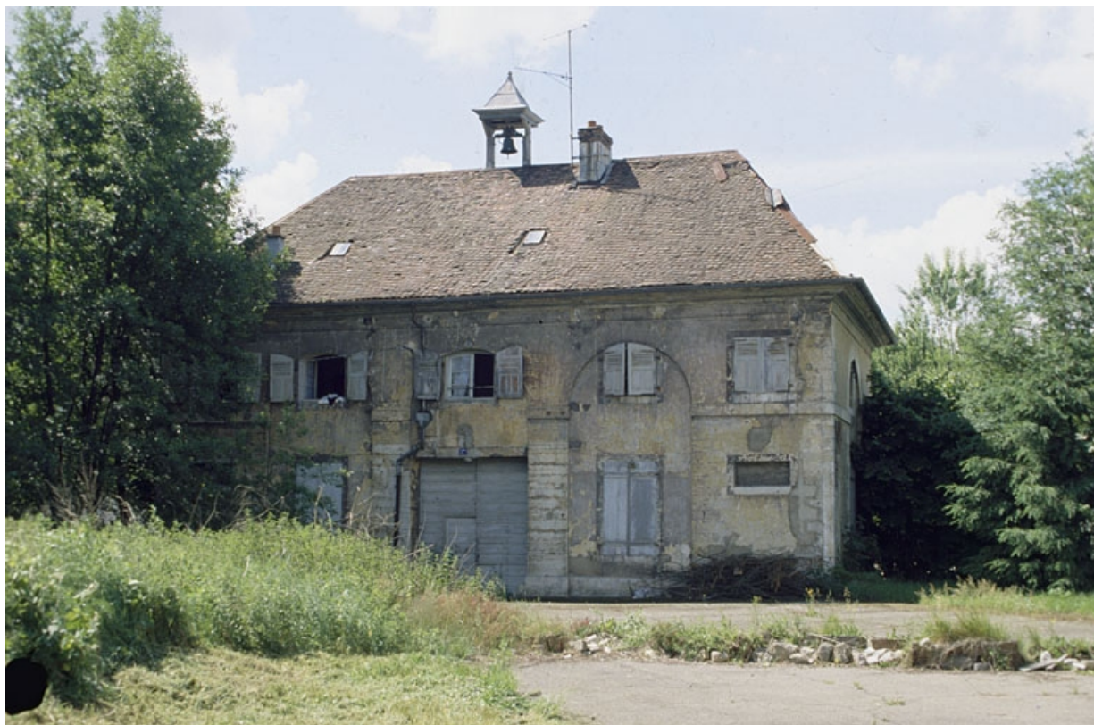
Façade postérieure des communs nord.
