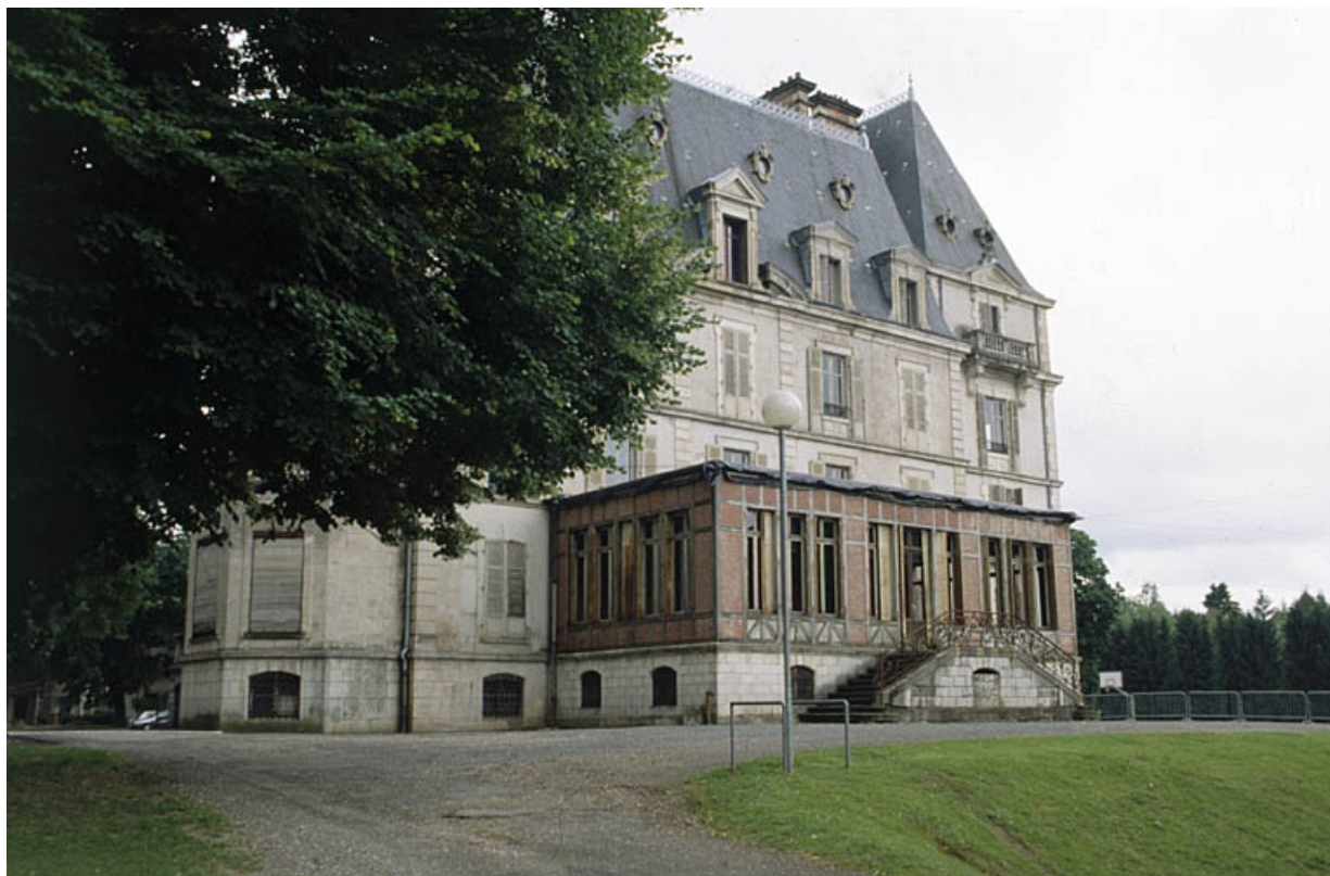
Façade postérieure vue de trois quarts gauche.
