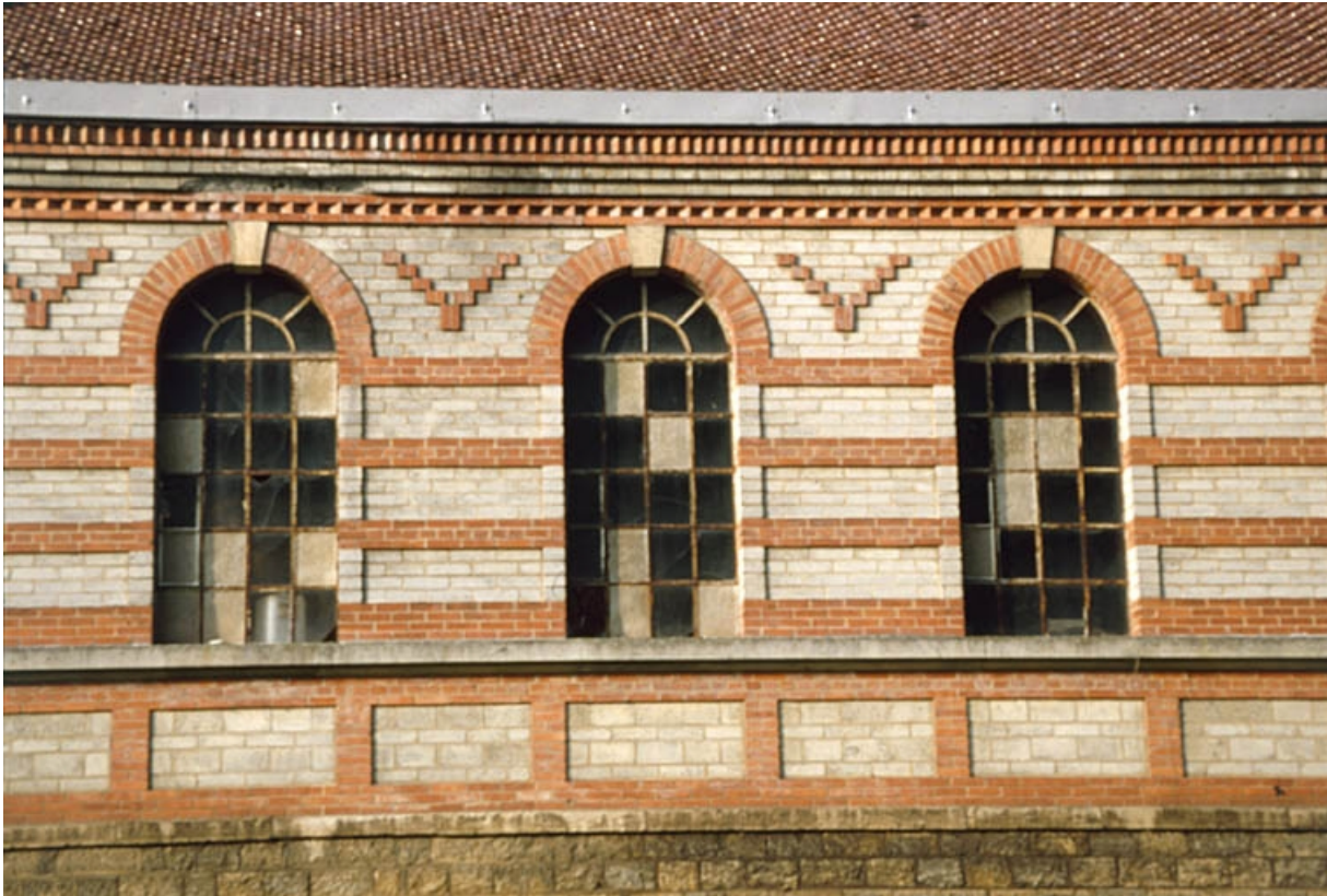
Détail de la façade est de l'orangerie.
