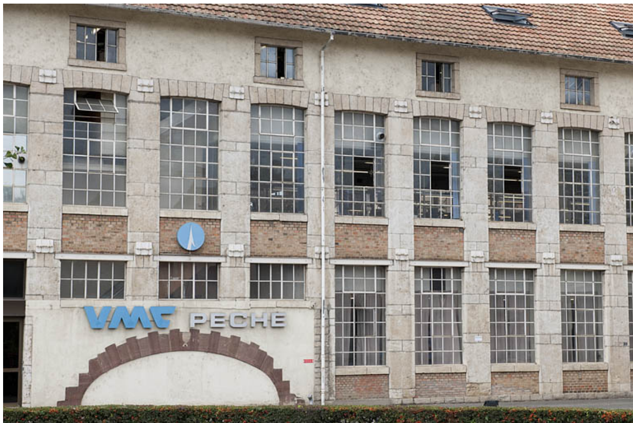
Détail de travées de la façade antérieure.
