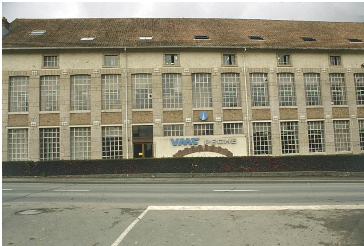
Façade antérieure vue de face.
