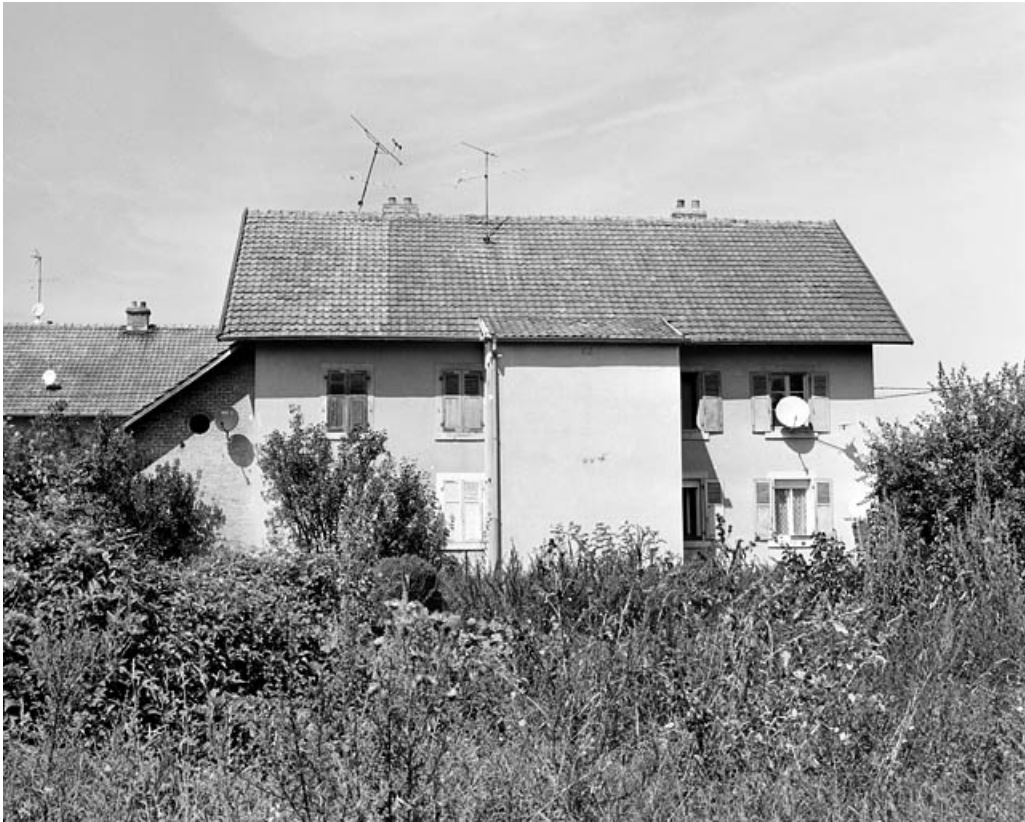
Façade postérieure d'un logement ouvrier collectif.
