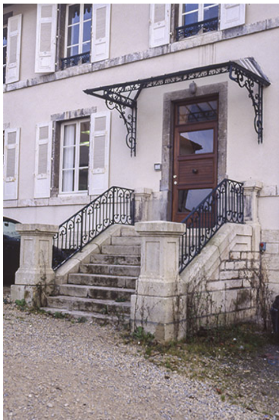
Perron du bâtiment des bureaux.
