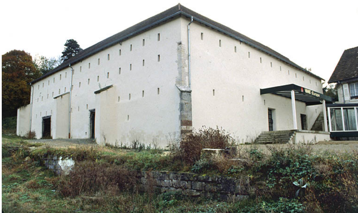
Ancienne halle à charbon depuis le nord-ouest.
