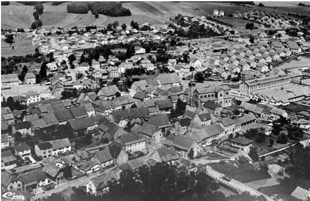
Grandvillars (T.-de-B.). La localité et les Usines du Château. Vue aérienne [l'usine dite du Château et les cités ouvrières Bellevue, Migeon, Alsacienne et des Creux].
