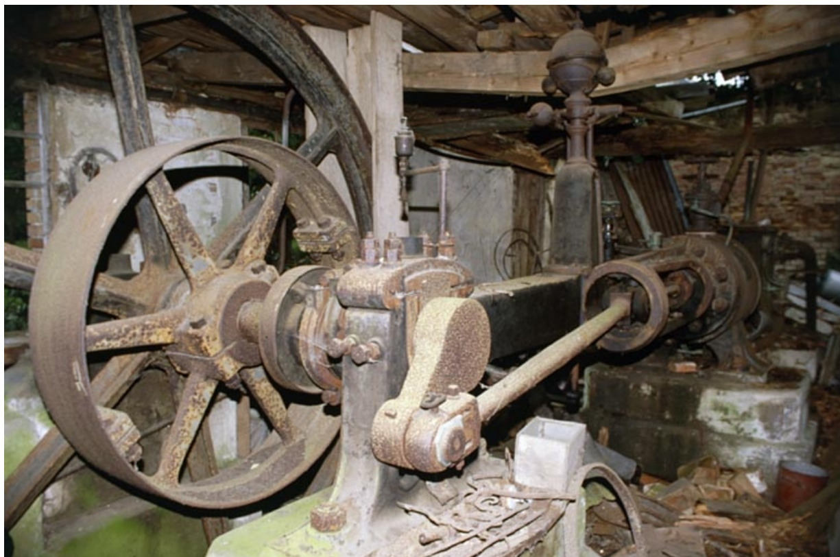
Vue d'ensemble de la machine à vapeur depuis le sud.
