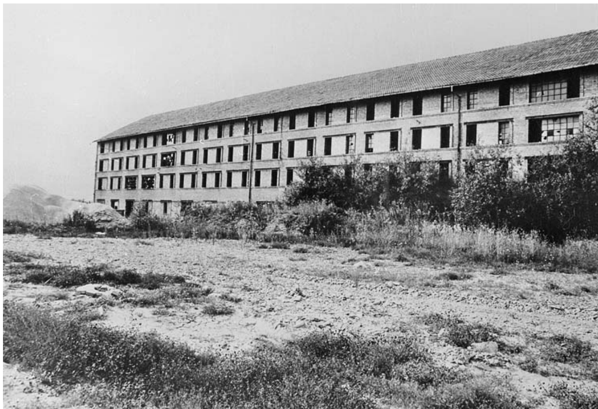
Façade de la nouvelle tuilerie vers 1980. 90, Froidefontaine, 2 à 7 rue André Viellard
