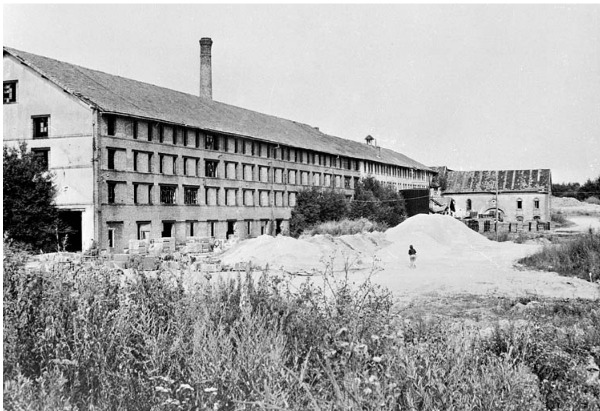
Ancienne et nouvelle tuilerie vers 1980.
