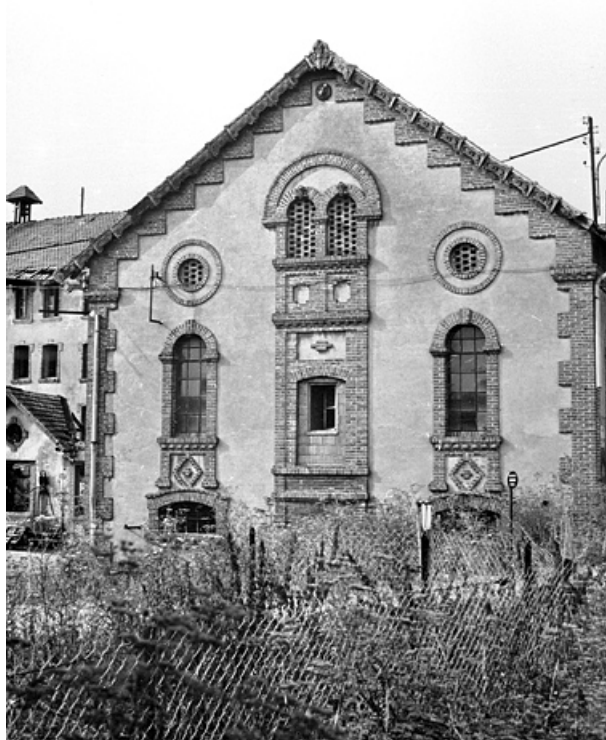
Mur-pignon de la briqueterie (?) vers 1980.
