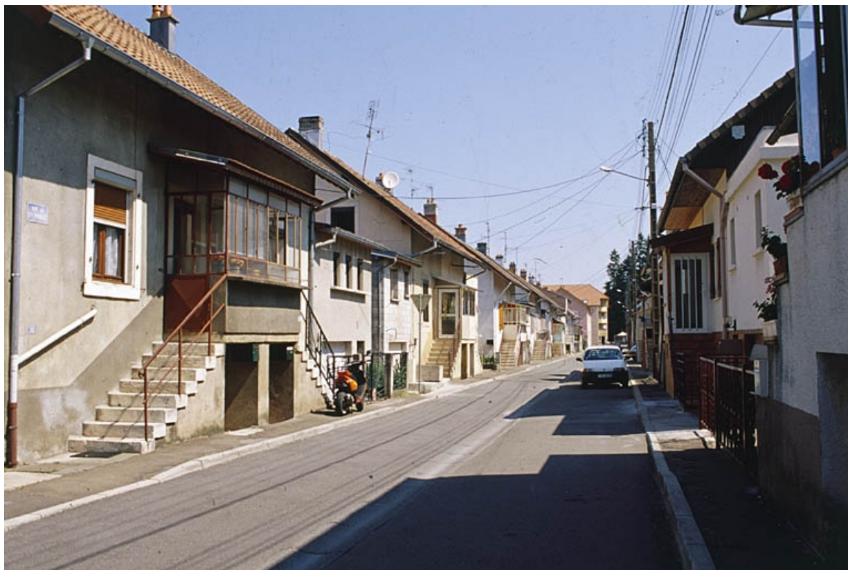
Logements ouvriers doubles rue du Commandant Prince.
